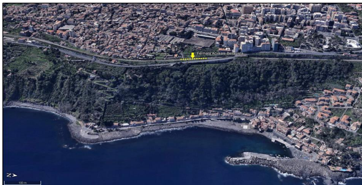
Figura 7 - Prospetto della "Timpa" in corrispondenza del sito della nuova fermata (Google Earth)
