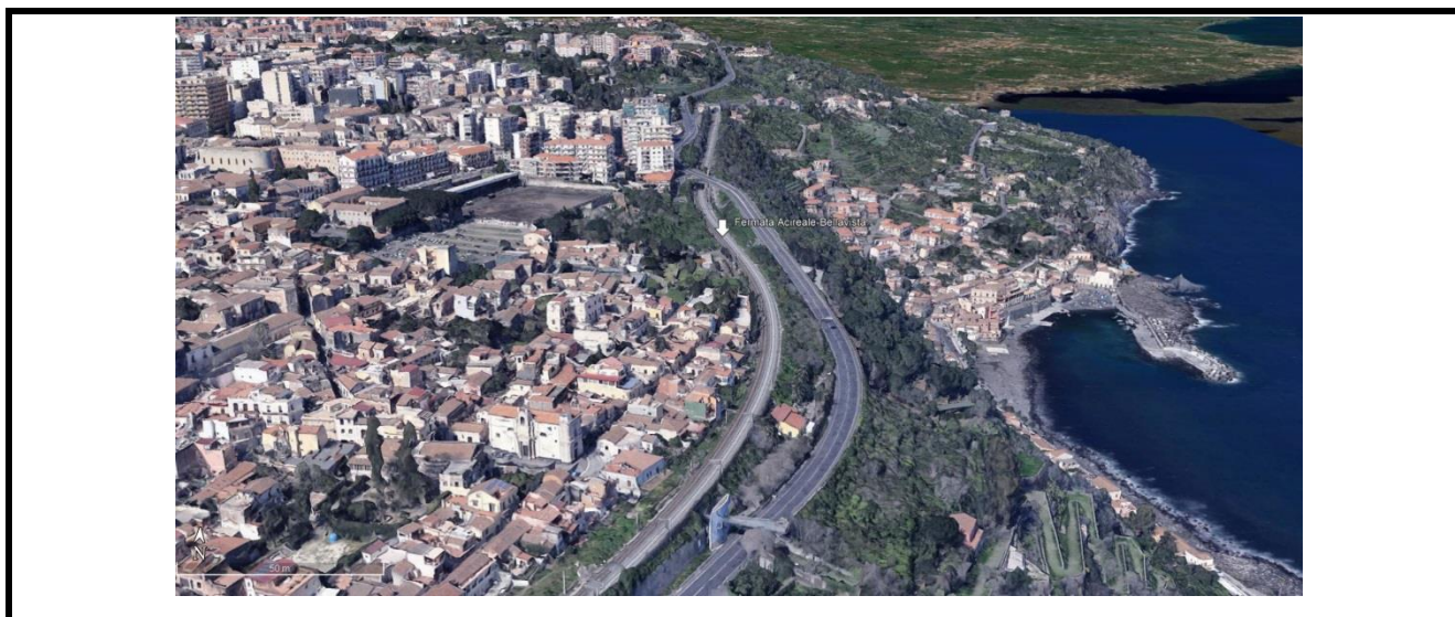
Figura 4 – Vista aerea di contesto
