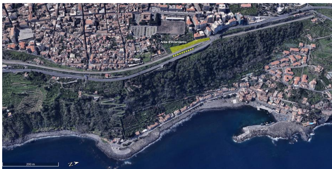
Figura 9 – Viste dell'area d'intervento nell'ambito urbano di contesto
