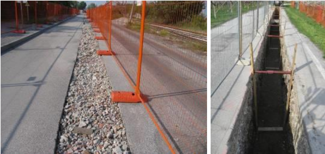
Figura 2-46. Taglio dell'asfaltatura e scavo aperto.
