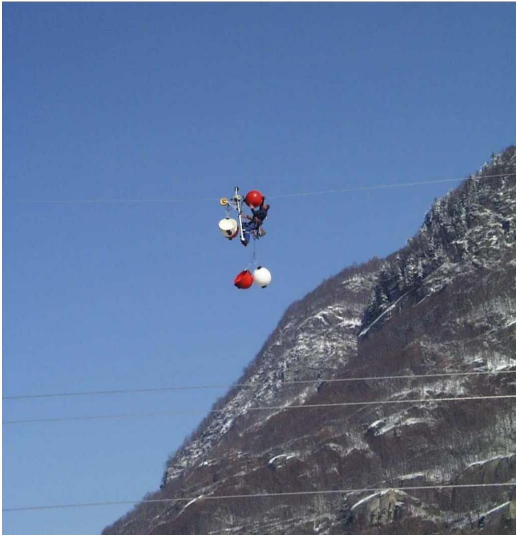
Figura 2-54 Installazione segnalatori ottici e ad acustici (sfere colorate in plastica).
