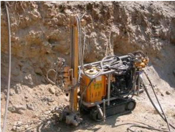
Figura 2-25. Esempio di fondazione con tiranti in roccia.
