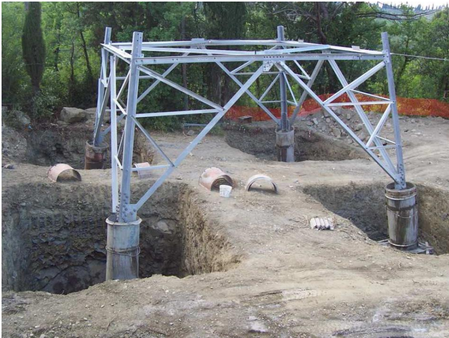
Figura 2-23. Esempio di fondazione di un sostegno.
