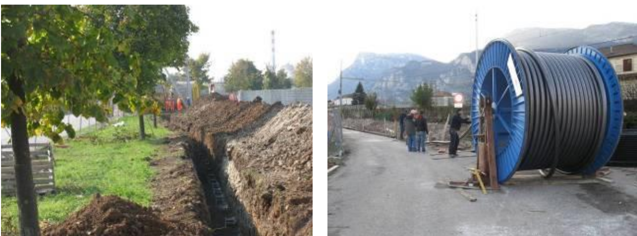
Figura 2-47. Posa rulli lungo lo scavo e stendimento del cavo.
