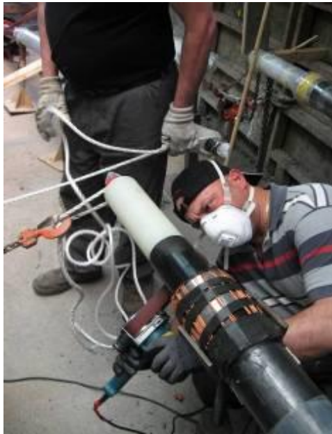
Figura 2-48. Esecuzione giunto.
