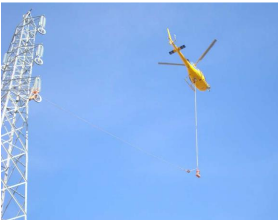
Figura 2-28. Utilizzo dell'elicottero per la stesura della corda pilota.
