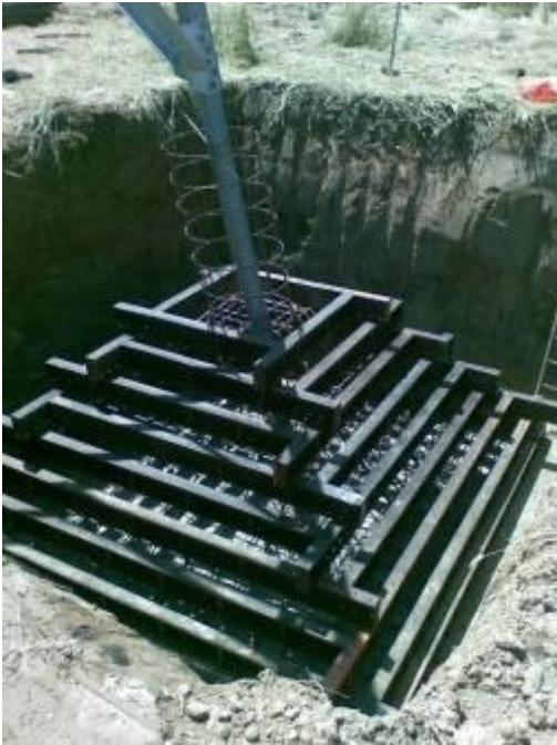
Figura 2-24. Esempio di realizzazione di una fondazione a plinto con riseghe.
