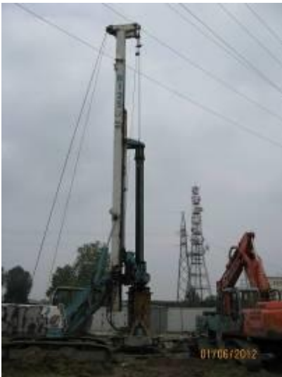
Figura 2-26. Esempio di realizzazione di una fondazione a trivellati
