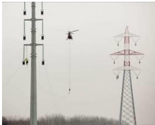
Figura 2-28. Utilizzo dell'elicottero per la stesura della corda pilota.
