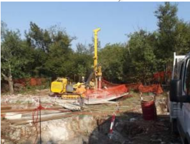
Figura 2-27. Esempio di realizzazione di una fondazione a micropali.
