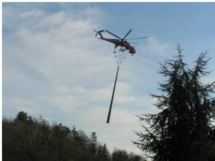
Figura 3-8 Trasporto di un sostegno con elicottero Erickson
