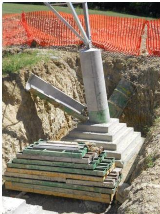
Esempi di fondazione di un sostegno
