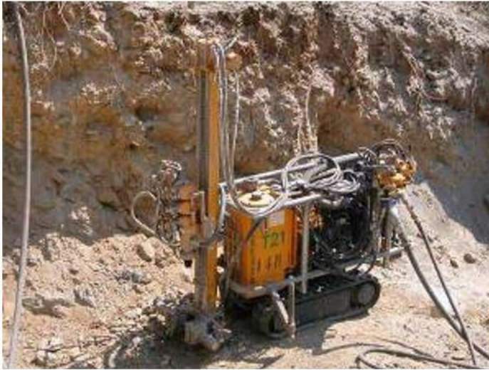
Esempio di fondazione con tiranti in roccia
