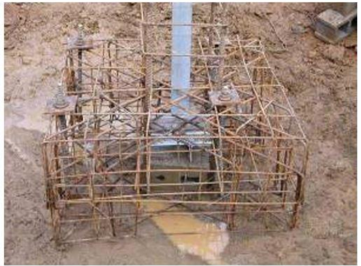
Esempio di fondazione con tiranti in roccia
