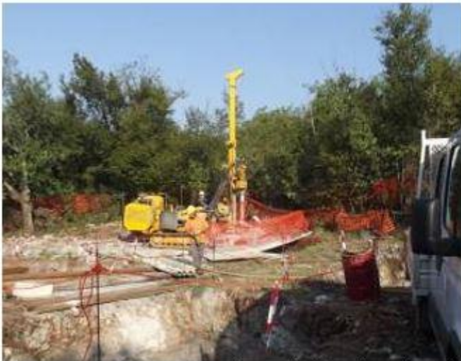
Esempio di realizzazione di una fondazione a micropali
