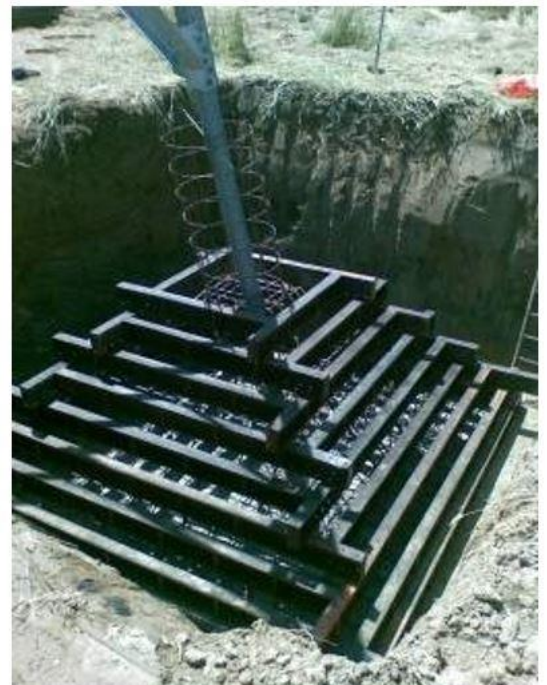
Esempio di realizzazione di una fondazione a plinto con riseghe
