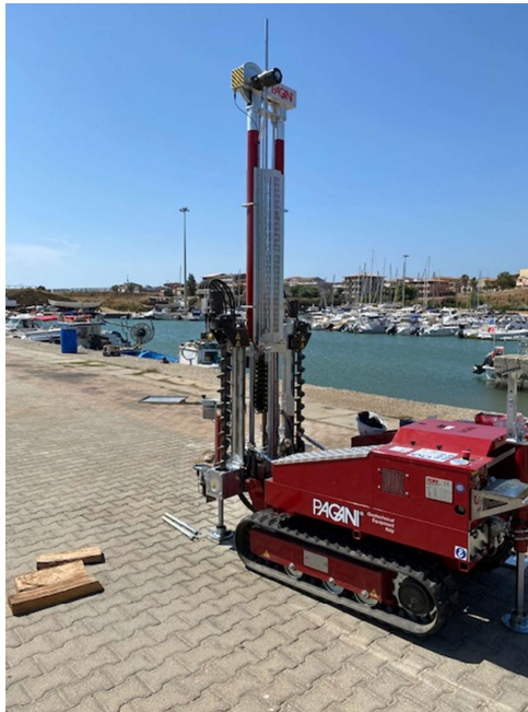
Figura 7.4 Posizionamento sonda TG-63 200 Pagani per esecuzione prova DPSH1
