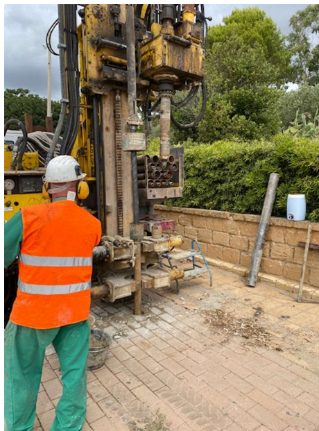
Figura 7.3 Esecuzione di prova SPT in sondaggio S5
