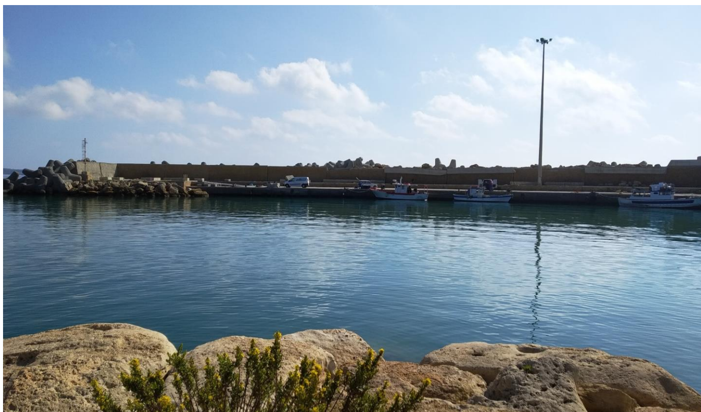
Foto 6 – Muro paraonde del molo sopraflutto
