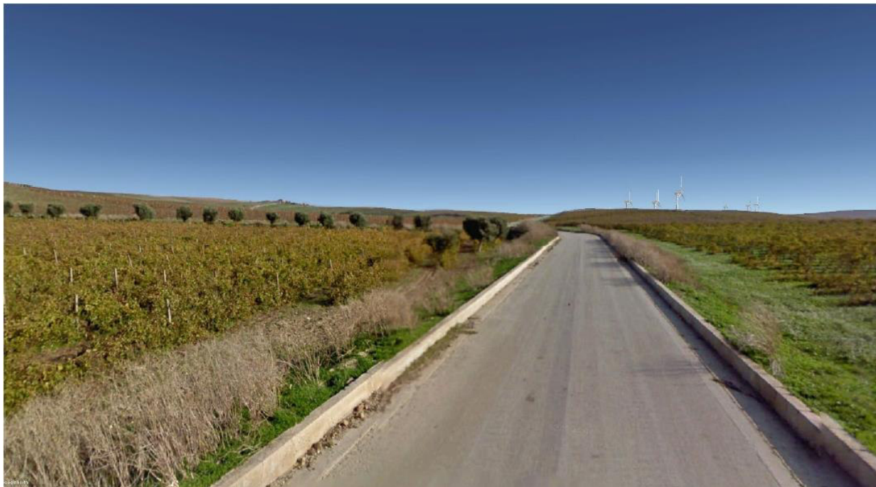
Fig. 2.7 – Vista 02: Stato dei luoghi ante operam
