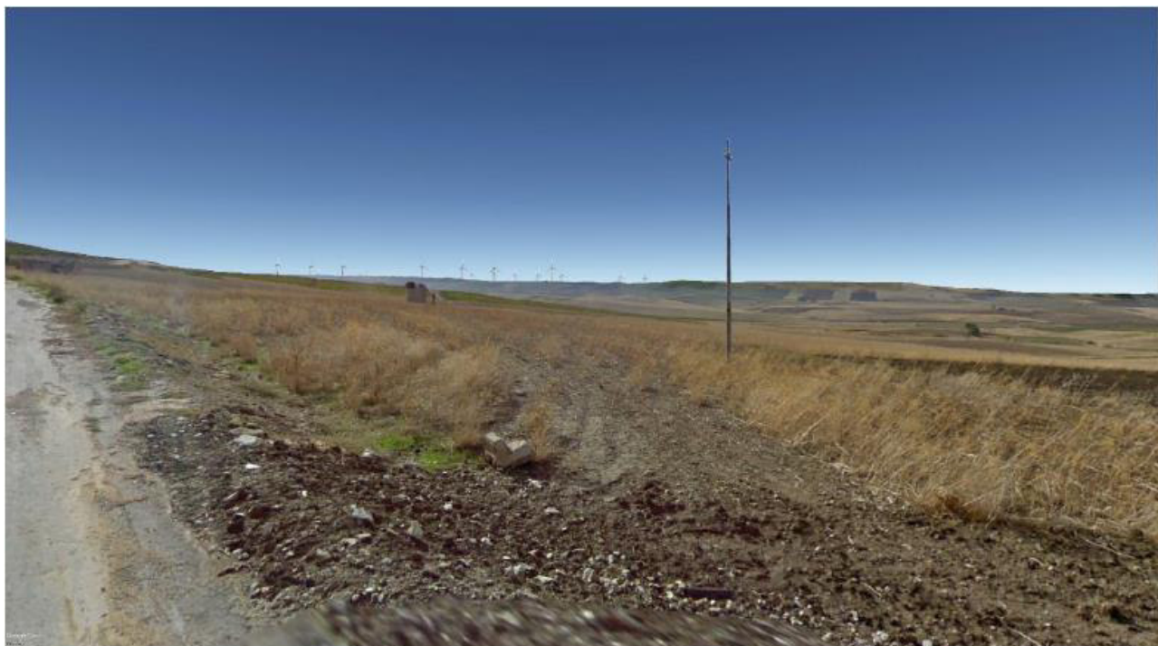
Fig. 2.15 – Vista 06: Stato dei luoghi ante operam
