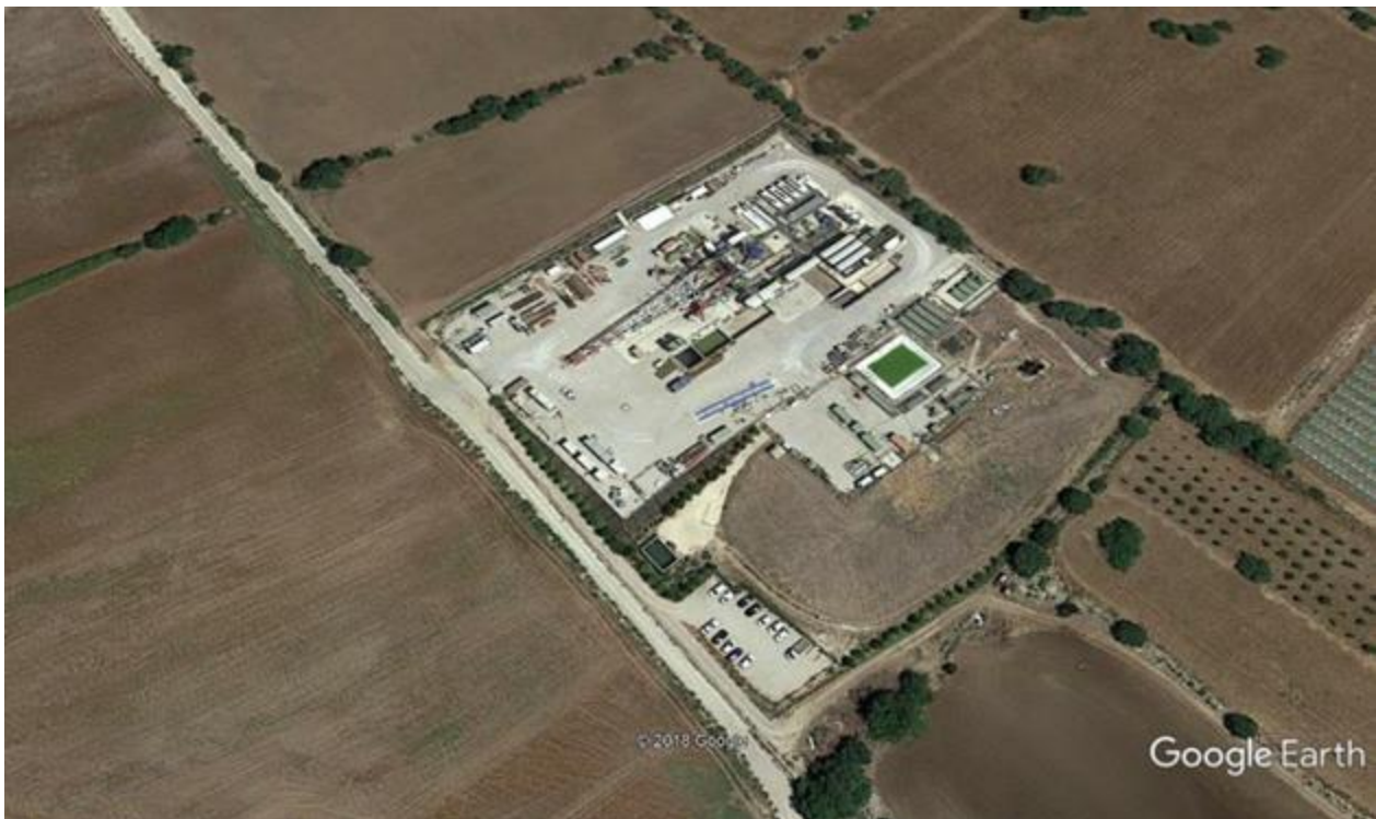
Figura 2– Immagine aerea della postazione Buglia Sottana. Si noti, a terra, l’impianto National 1320
