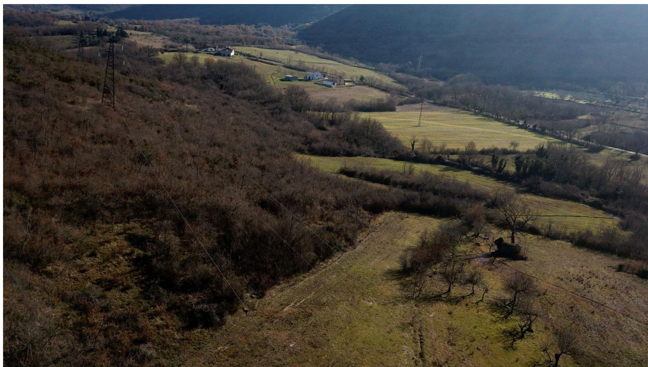
FOTO N°1 – AREA POSIZIONE FUTURO SOSTEGNO P17 e P961-19/1 VISTA DA DRONE
