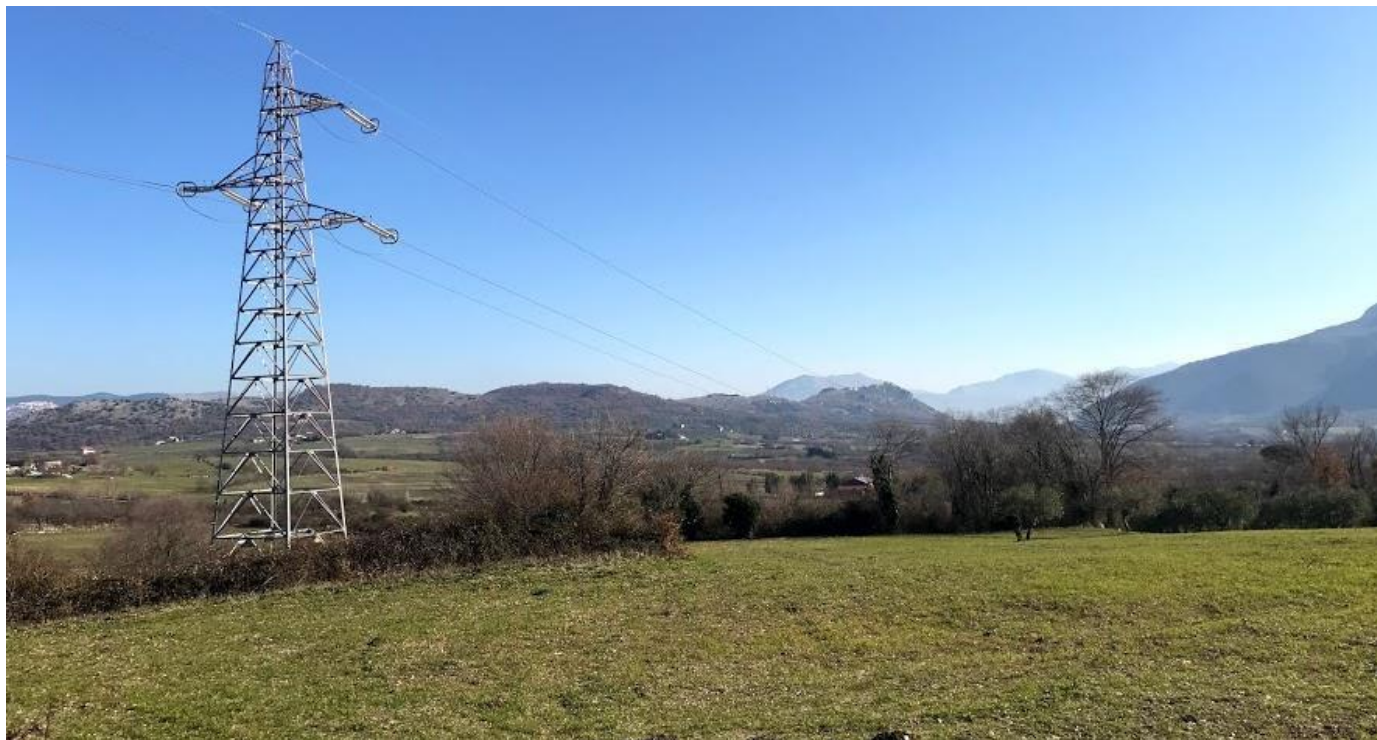
FOTO N°1 – AREA POSIZIONE FUTURO SOSTEGNO P8 VISTA DA O
