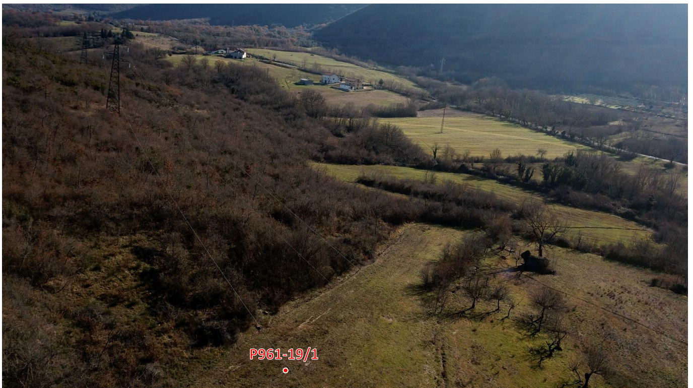
Figura 27: Sostegno P961-19/1 - su carta della pericolosità da frana (in alto) e da foto con drone
