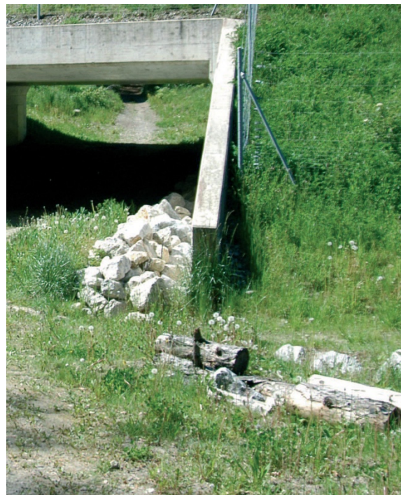
Esempio di macereti e cataste di legna predisposte agli imbocchi dei tombini
