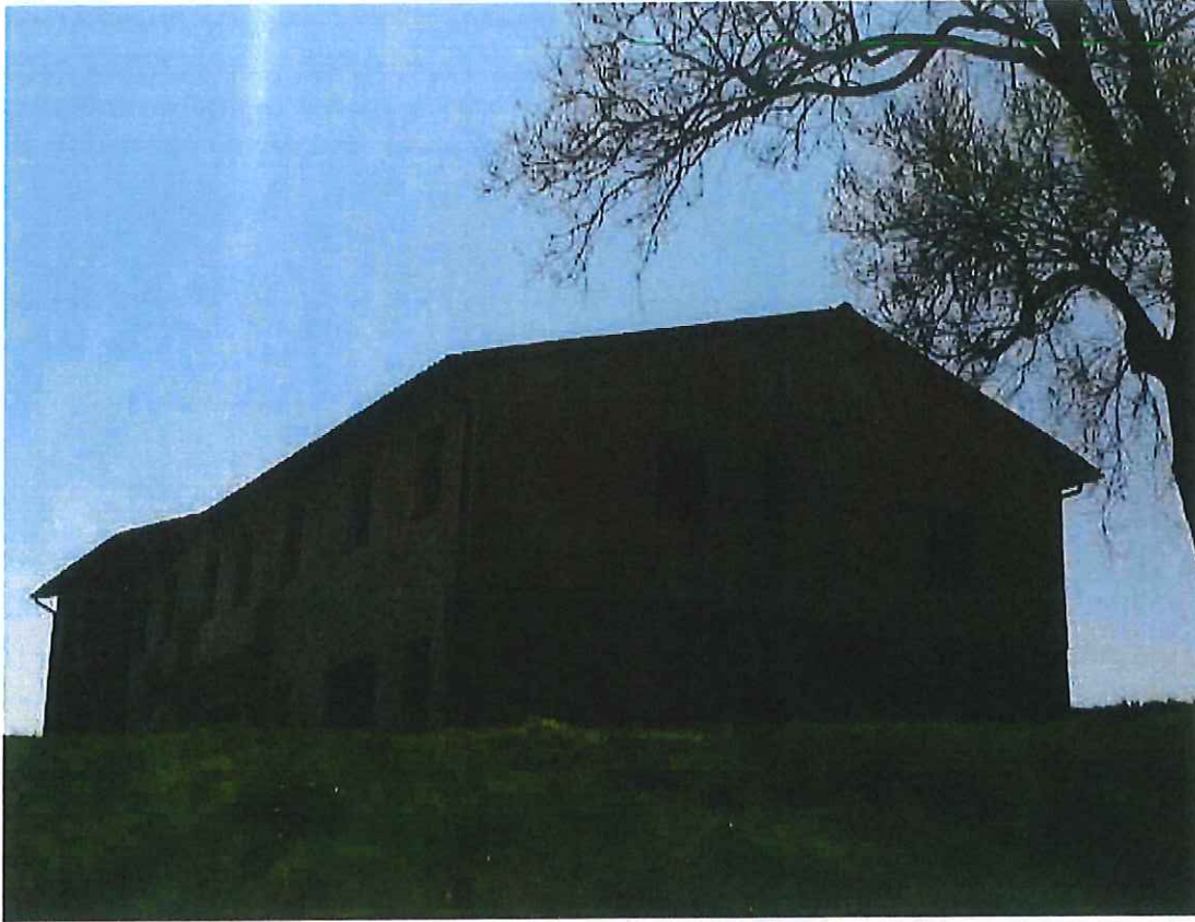
Collepere: fabbricato rurale recentemente ristrutturato
