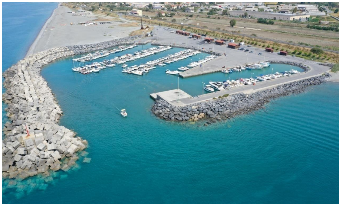
Figura 3 - Vista d'insieme (ottobre 2019)
