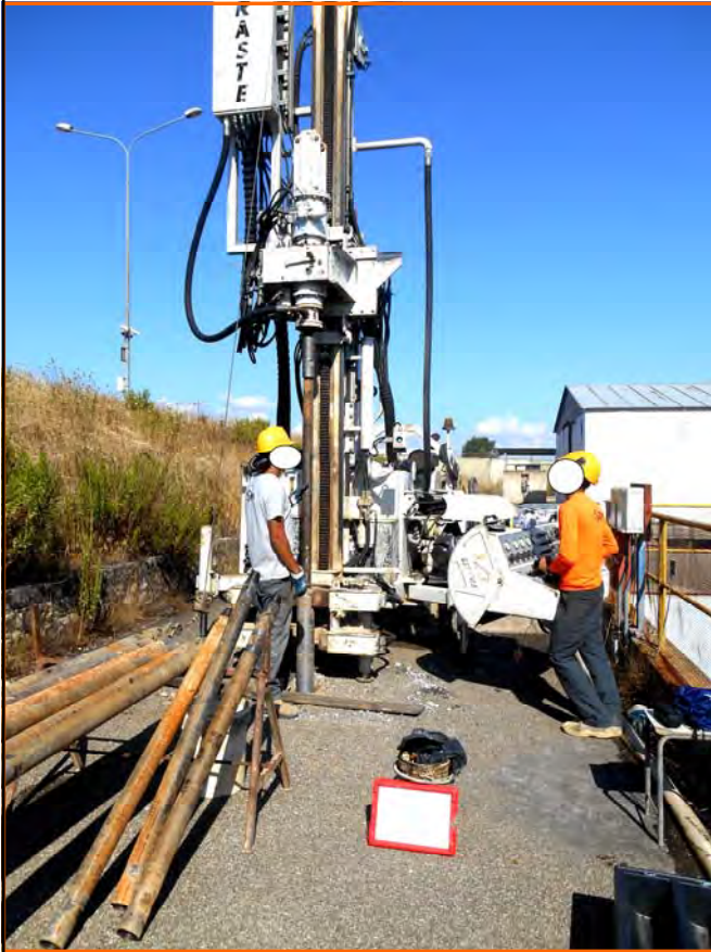
Postazione sondaggio S04
