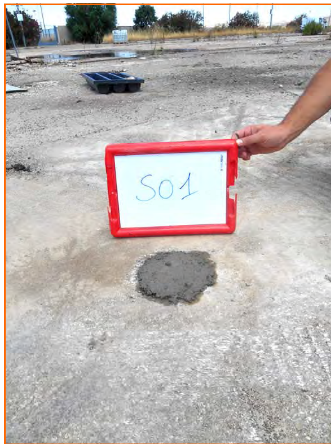
Foro Sondaggio S01 cementato
