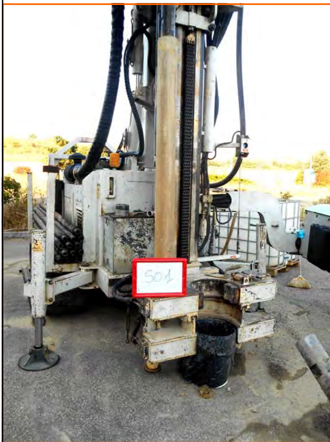
Postazione sondaggio S01
