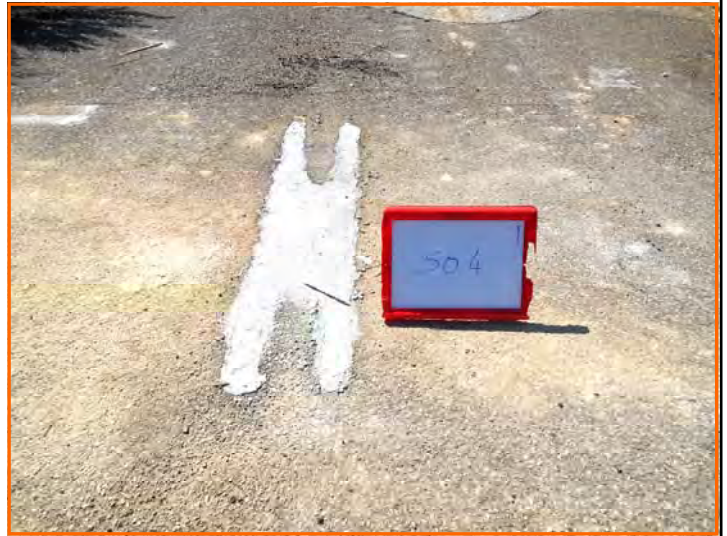
Foro Sondaggio S01 cementato
