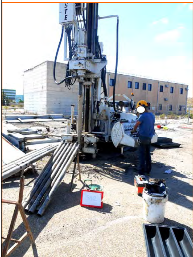
Postazione sondaggio S02
