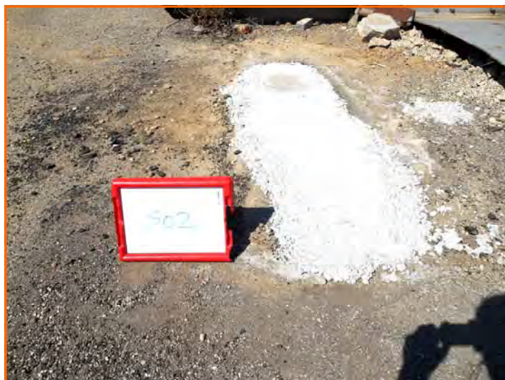
Foro Sondaggio S02 cementato
