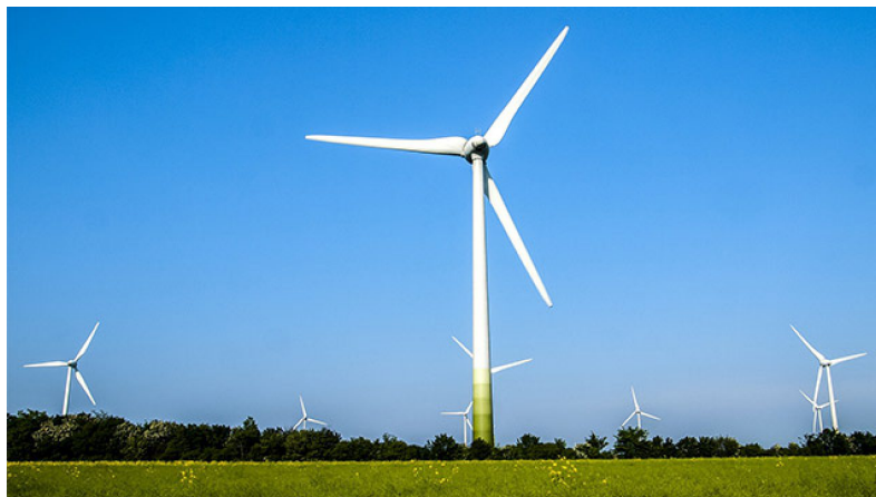
Figura 9-3: Esempio di gradazione cromatica alla base del palo e barriere vegetali.
