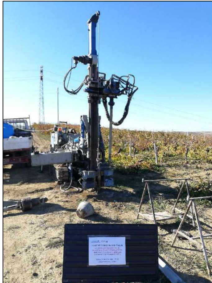
Figura 7. Sonda oleodinamica su cingoli “Soiltek S16” (postazione sondaggio T3 MM2-T3_12_S3).
