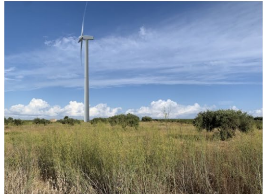
Ripresa post operam
