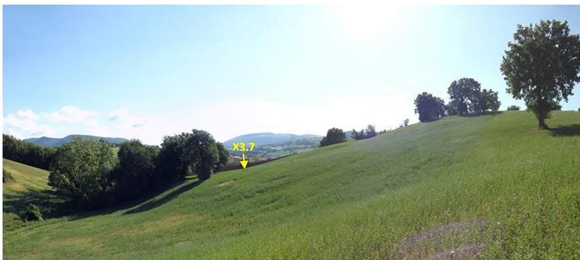
Panoramica da nord e da est dell'area in dissesto
