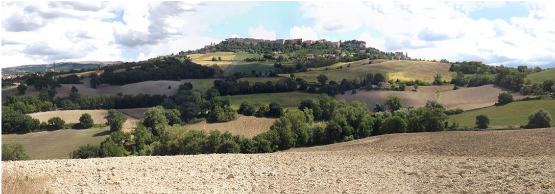
Panoramica da ovest del versante in frana
