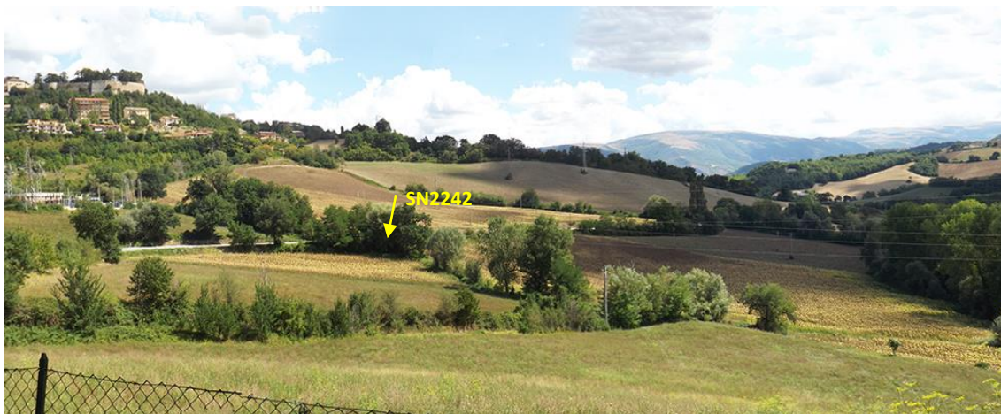
Panoramica da nord-ovest del versante in frana
