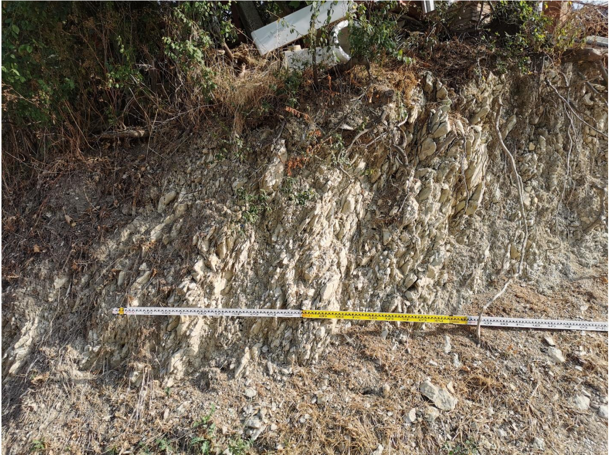
Figura 4.2 Particolare dello Schlier in affioramento nella stazione 2 in cui sono stati eseguiti i rilievi geostrutturali (azimut linea di scansione: N20°E).
