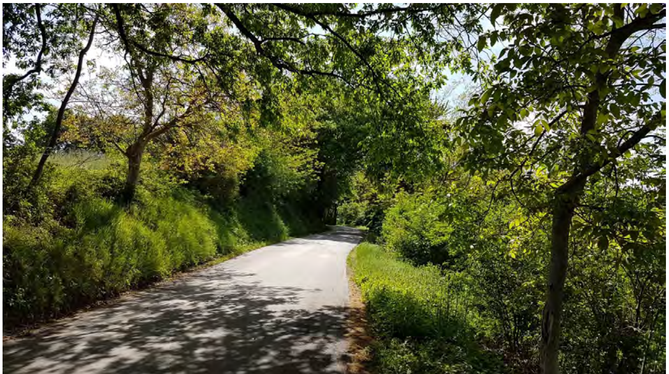
Foto 24 - Settore di scarpata a copertura arborea rada o assente
