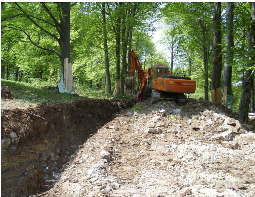
Figura 2-6 Foto tipica di scavo della trincea
