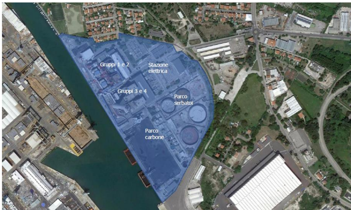
Figura 2 Vista aerea (risalente al 2015) della centrale con individuazione delle aree operative
