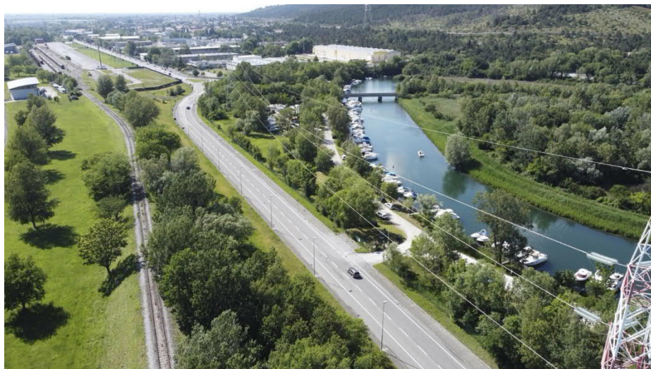
Figura 2: area di attraversamento del canale Tavoloni, di via Consiglio d'Europa e del raccordo ferroviario; veduta da S-E.
