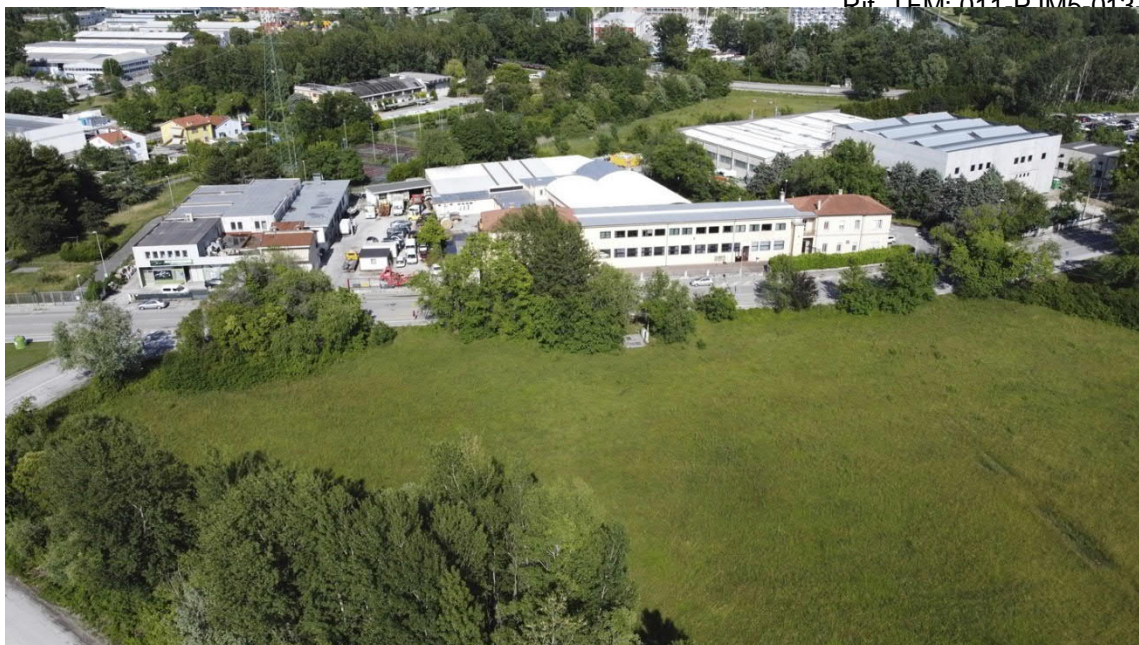
Figura 31: ultimo tratto interessato dai lavori; foto aerea, ripresa da O (fig.9, punto 22).
