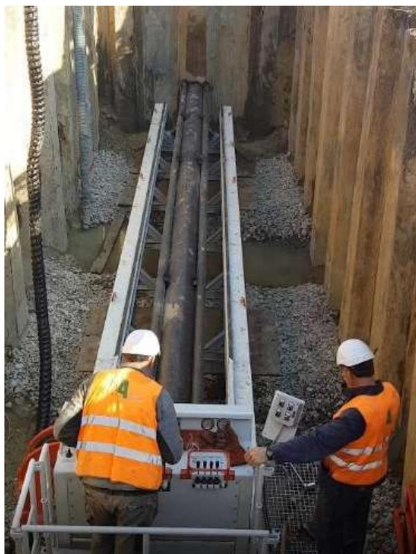
*Figura 2-5 – Esecuzione di trivellazione spingitubo*
