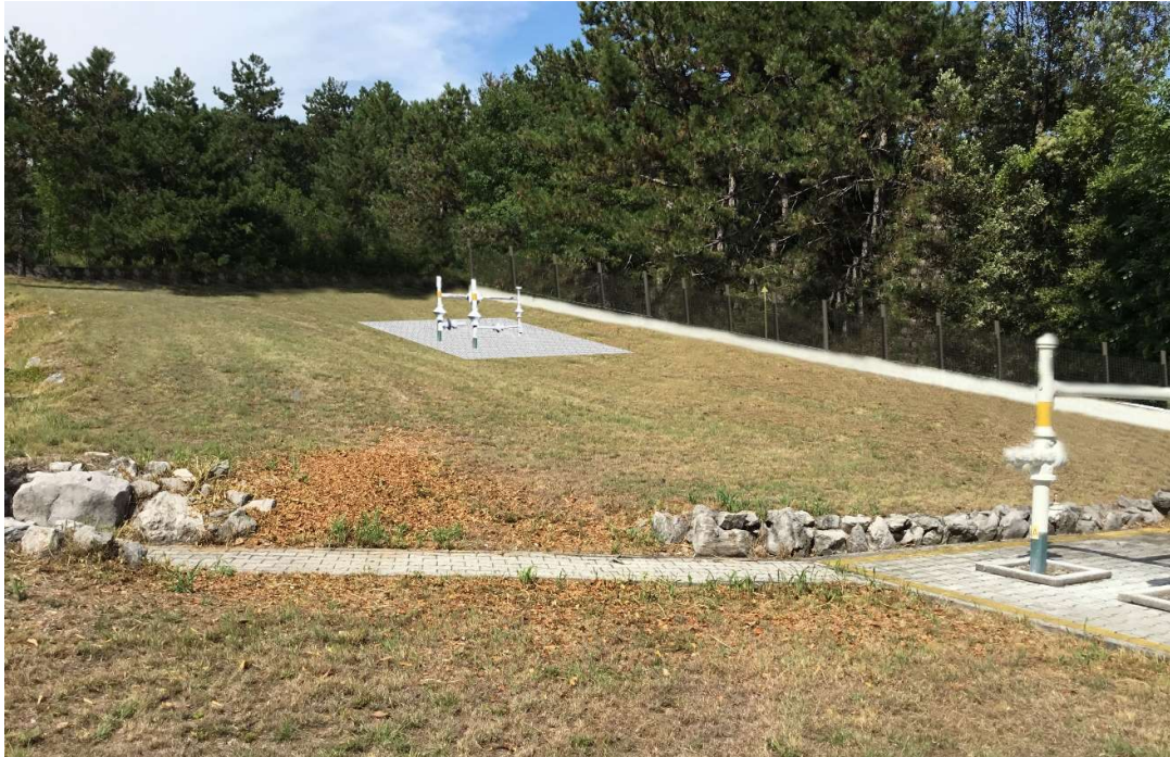
Figura 3-4 – Area cabina esistente n. 906/A in cui è previsto il PID1 n. 1 e area boscata limitrofa – Post operam a ripristini effettuati
