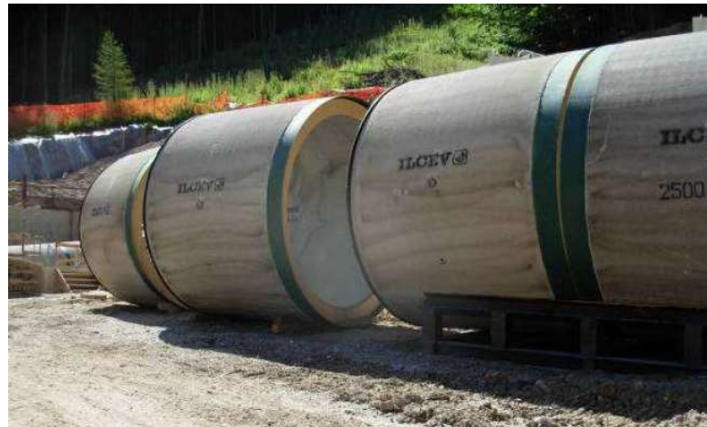
Figura 8-7 - Stoccaggio tubi in c.a.
