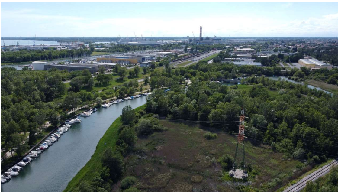
Figura 3-5 – Vista aerea del primo tratto con attraversamento del Canale Tavoloni
