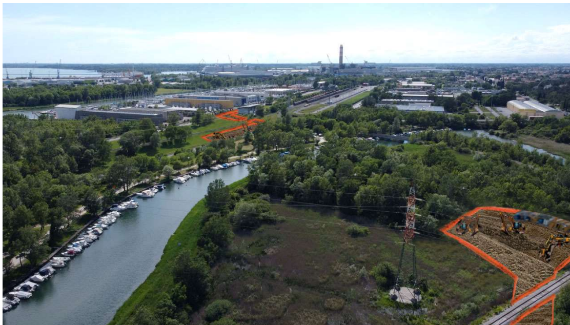
Figura 3-6 – Vista aerea del primo tratto con attraversamento del Canale Tavoloni – Corso d'opera
