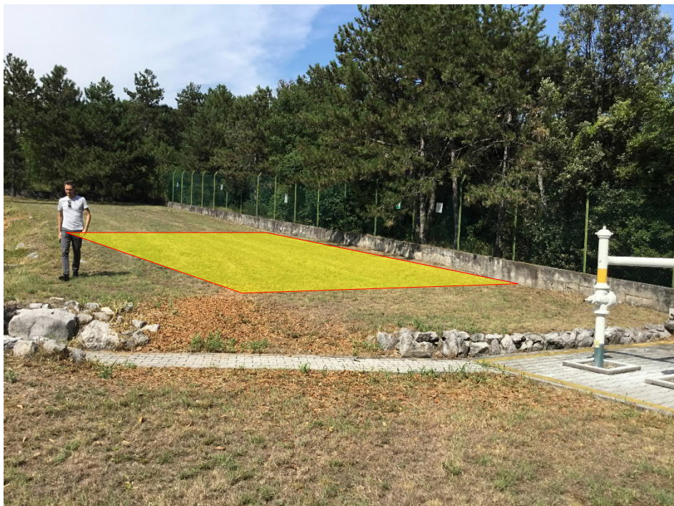
FOTO N.1 – Stacco all'interno dell'esistente cabina n.906/A in comune di Monfalcone
