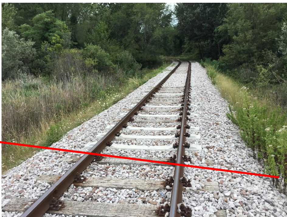
FOTO N.6 – Attraversamento raccordo ferroviario base All. Cartiera Burgo
