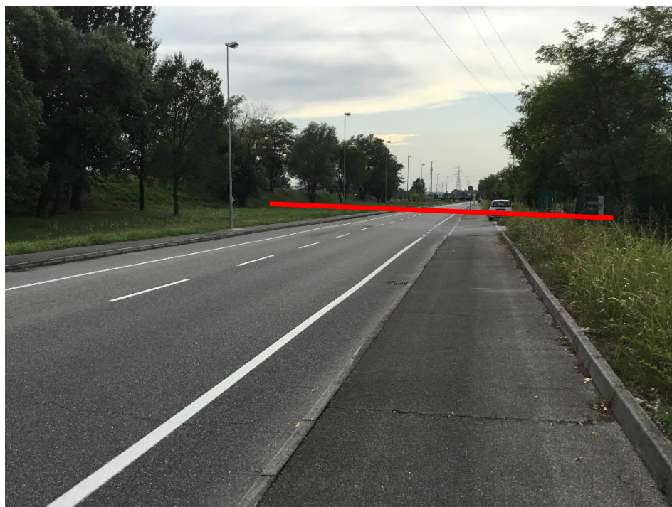
FOTO N.8 – Attraversamento via Consiglio d'Europa
