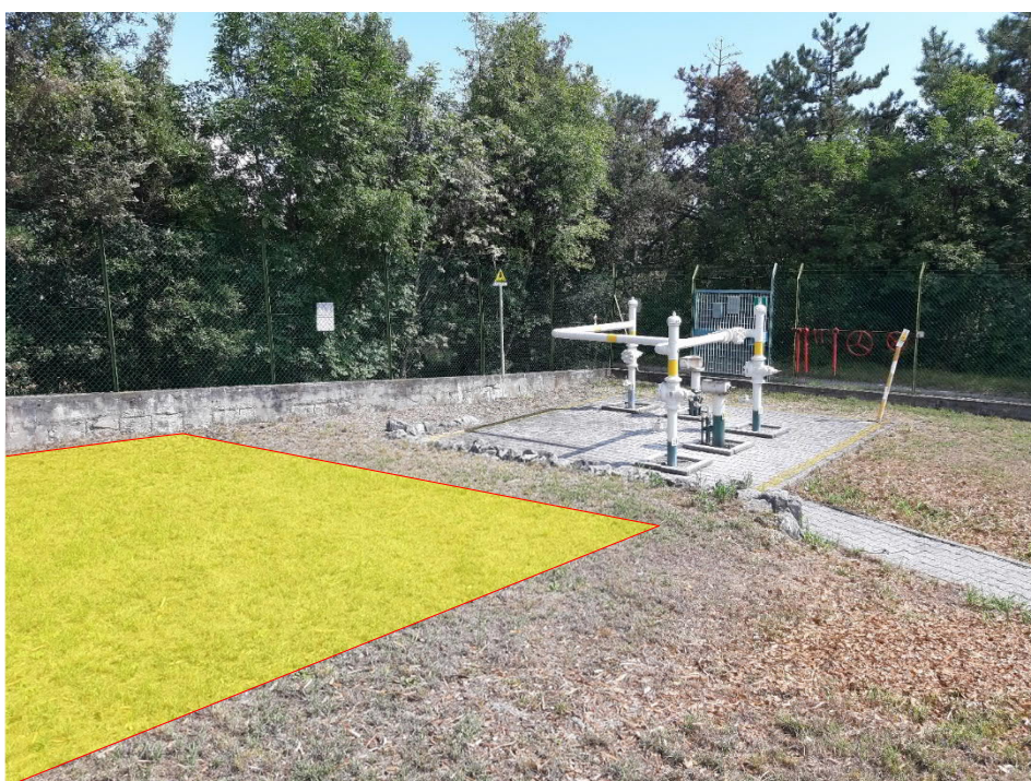
FOTO N.2 – Stacco all'interno dell'esistente cabina n.906/A in comune di Monfalcone
