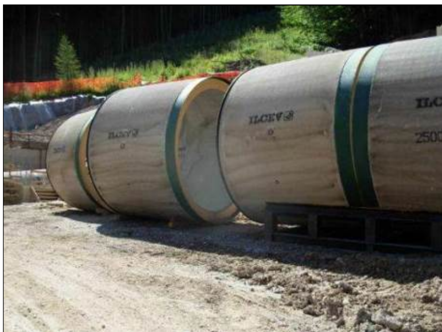
Fig. 2.13/D – Stoccaggio tubi in c.a.
