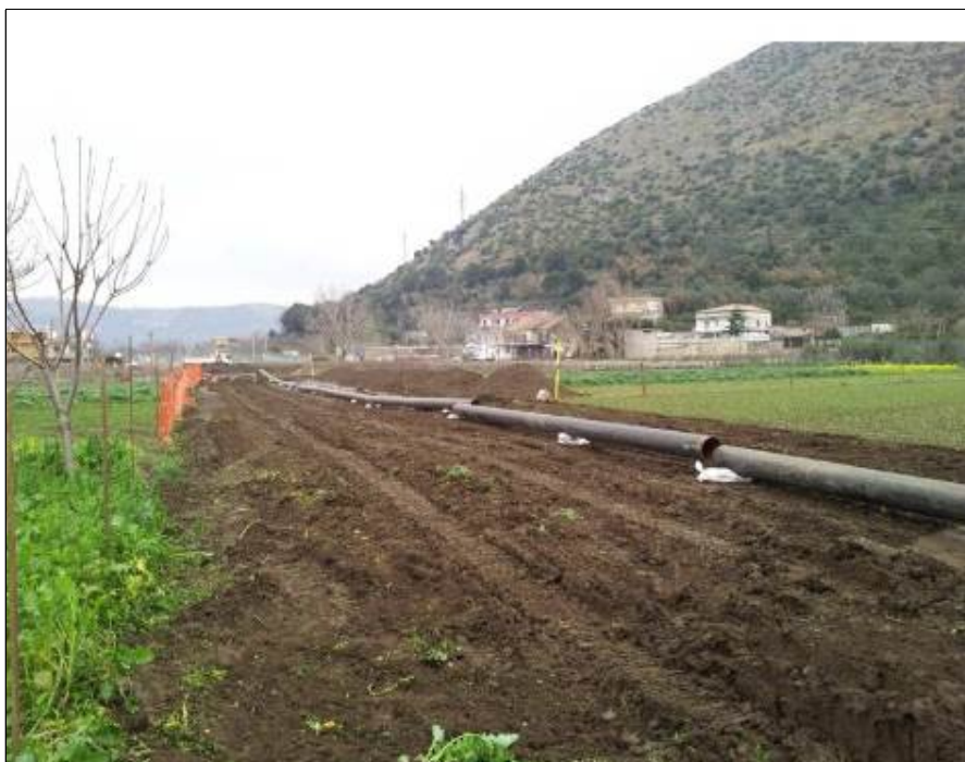
Fig. 2.6/A - Sfilamento tubazioni
