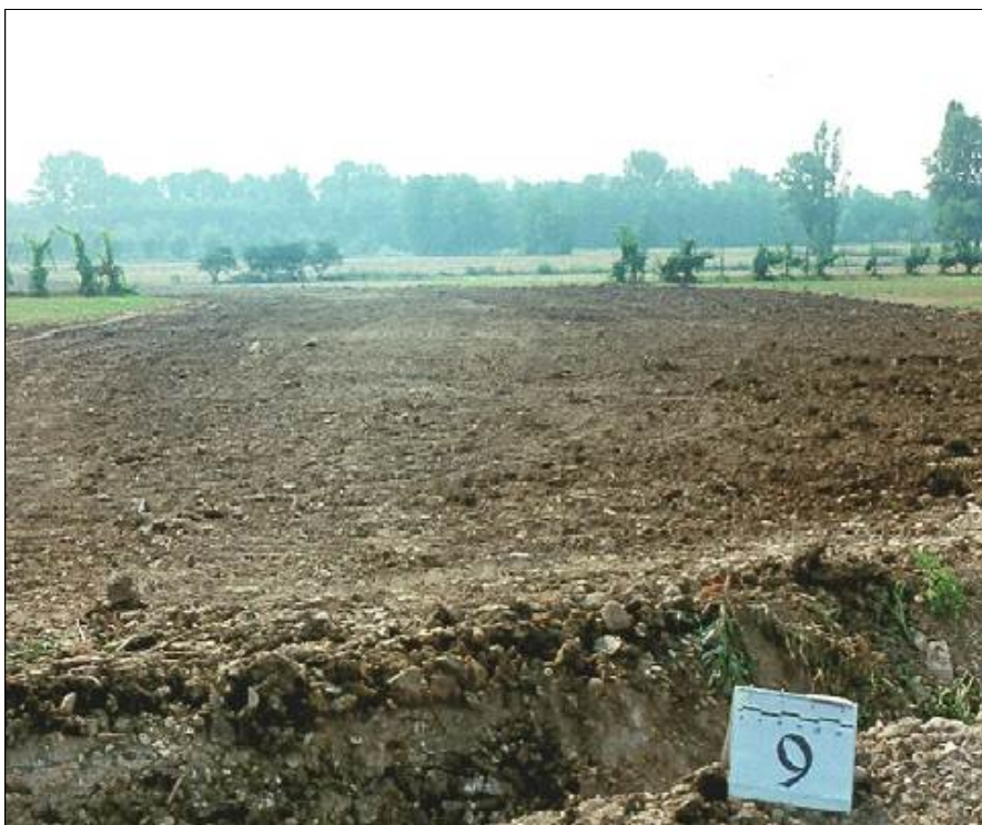
Fig. 2.12/A - Rinterro della condotta
