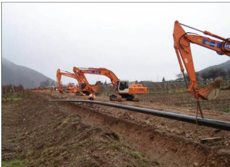
Fig. 2.11/A - Posa della condotta
