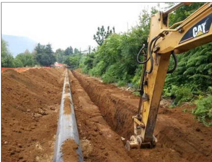
Fig. 2.9/A - Scavo della trincea
