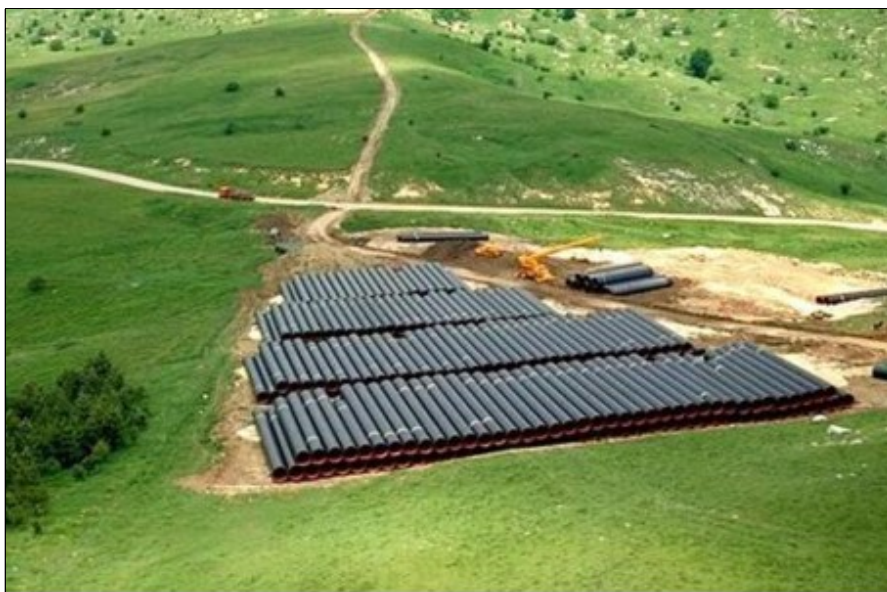
Fig. 2.4/A - Foto tipica di una piazzola per accatastamento tubazioni
