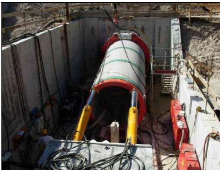
Fig. 2.13/B – Postazione di spinta
