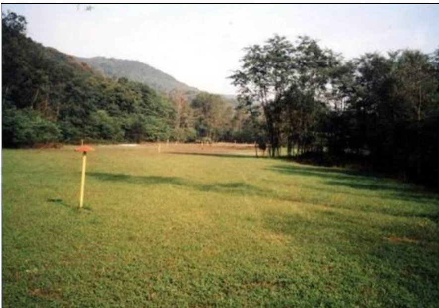
Fig. 2.16/A –Pista lavori a ripristini ultimati su gasdotto in esercizio
