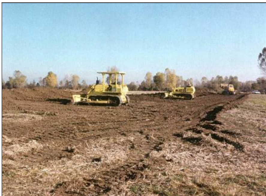
Fig. 2.5/A - Apertura pista di lavoro
