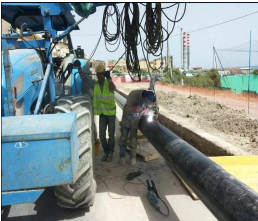
Fig. 2.7/A - Foto tipica della fase di saldatura
