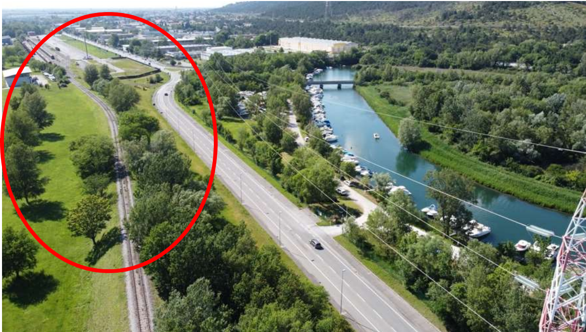
Figura 4-47 - tratto settentrionale di via Consiglio d'Europa e i binari ferroviari; ripresa aerea, veduta da Est
