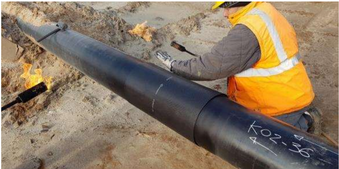
Figura 2-15 – Applicazione manuale di una fascia termorestringente su giunto di saldatura
