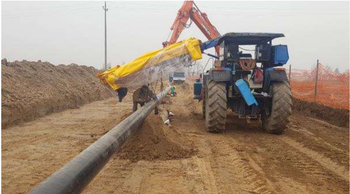
Figura 2-12 – Fase di saldatura manuale
