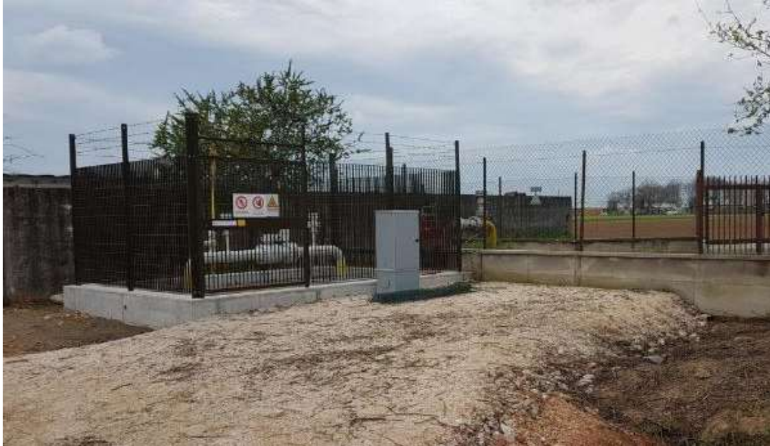
Figura 2-28 – Esempio di impianto al termine dei lavori
