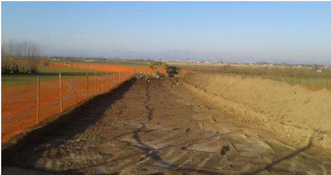
Figura 2-9 – Foto di apertura della pista di lavoro
