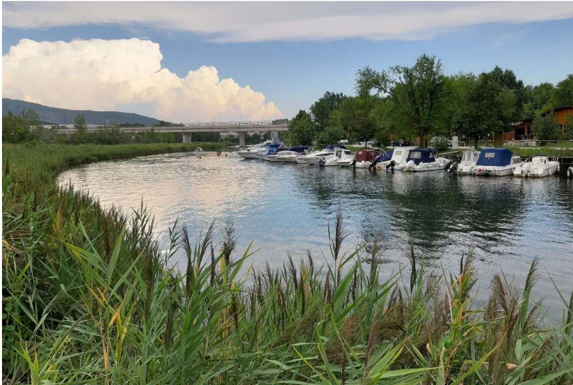
Figura 2-3 – Panoramica dal canale dei Tavoloni che la tubazione attraverserà in trenchless
