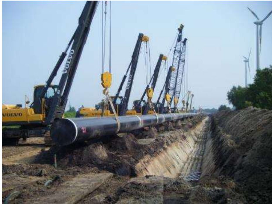
Figura 2-16 – Posa della condotta
