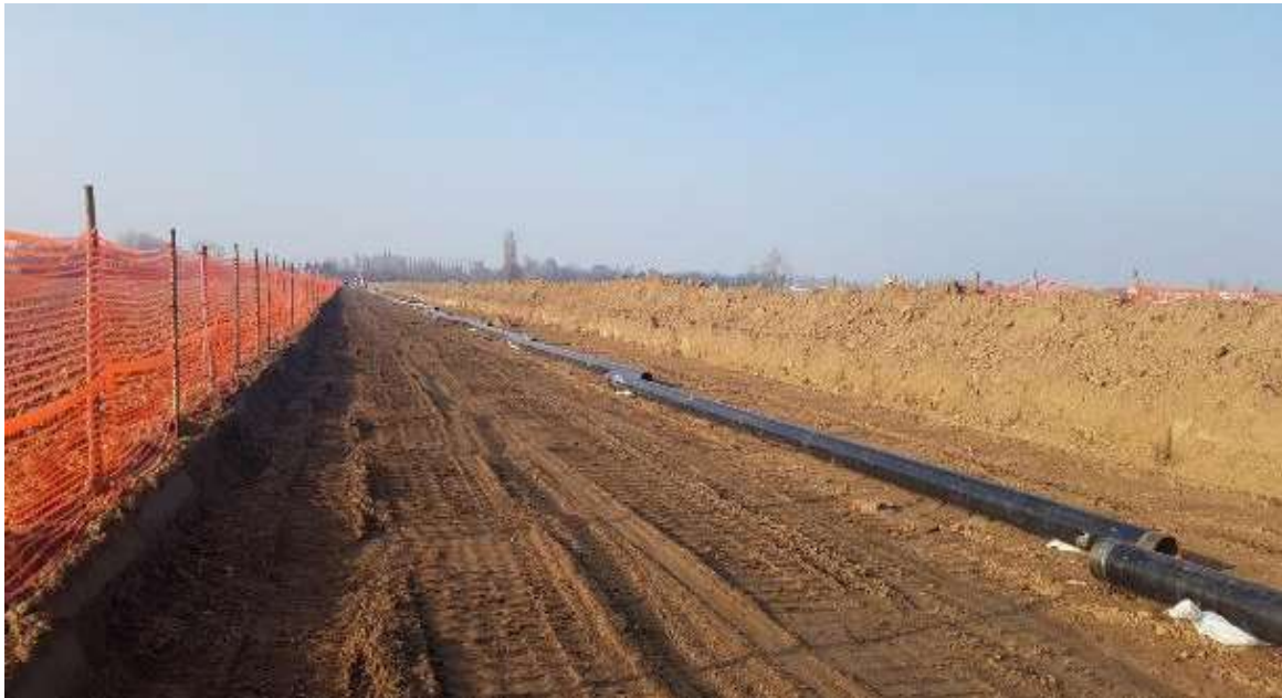
Figura 2-11 – Sfilamento delle tubazioni di linea
