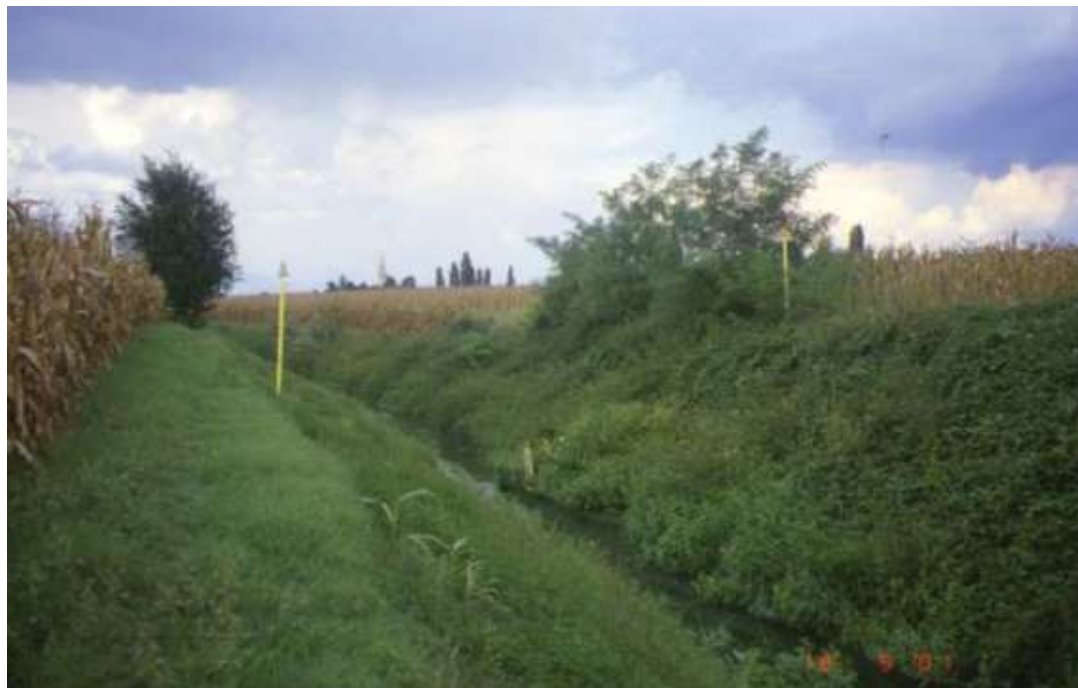
Figura 2-34 – Esempio di opera ultimata in corrispondenza di attraversamento di corso d'acqua in ambito agricolo
