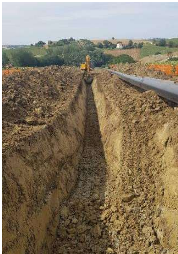
Figura 2-14 – Scavo della trincea
