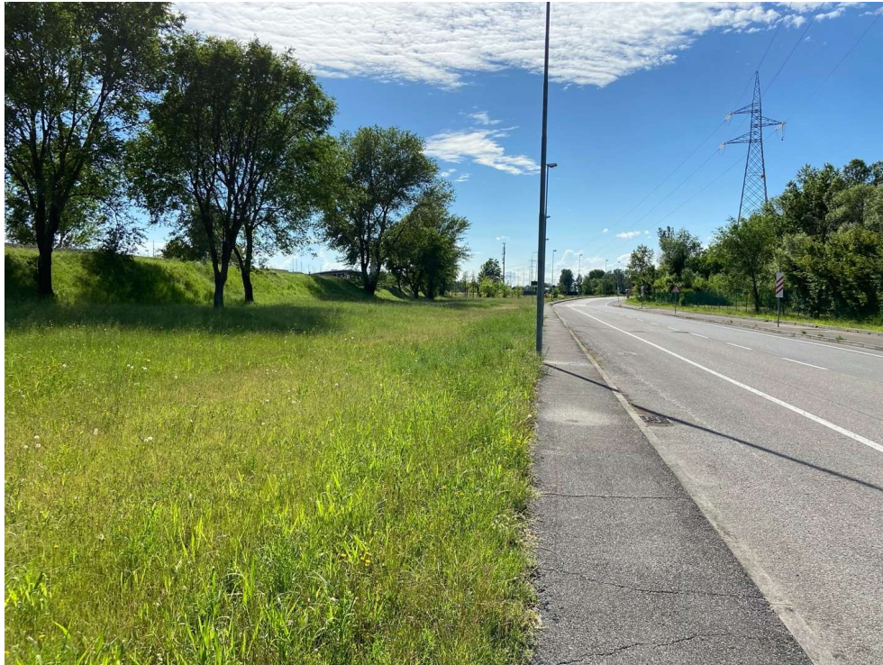
Figura 4-48 - tratto settentrionale di via Consiglio d'Europa; ripresa da EST
