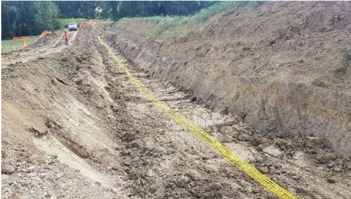
Figura 2-17 – Rinterro della condotta
