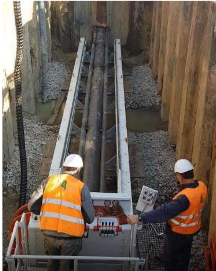
Figura 2-21 – Esecuzione di trivellazione spingitubo
