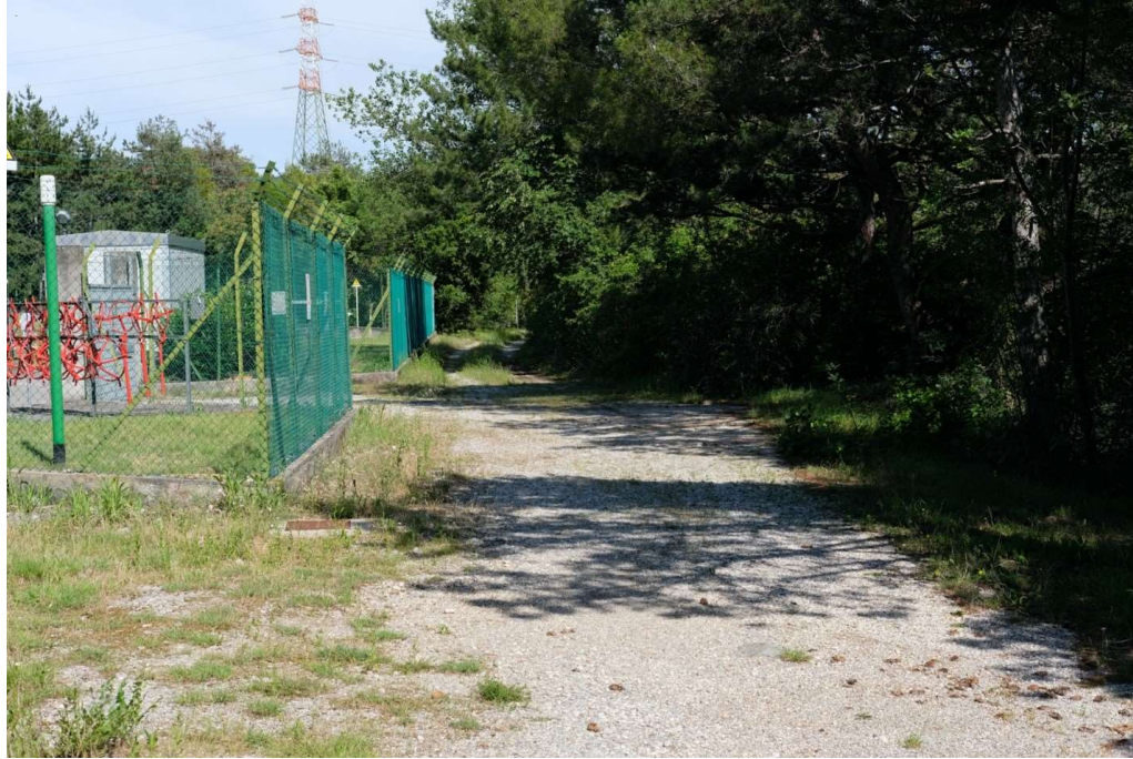
Figura 4-41 - cabina esistente n.906/A e strade di accesso; ripresa da OVEST
