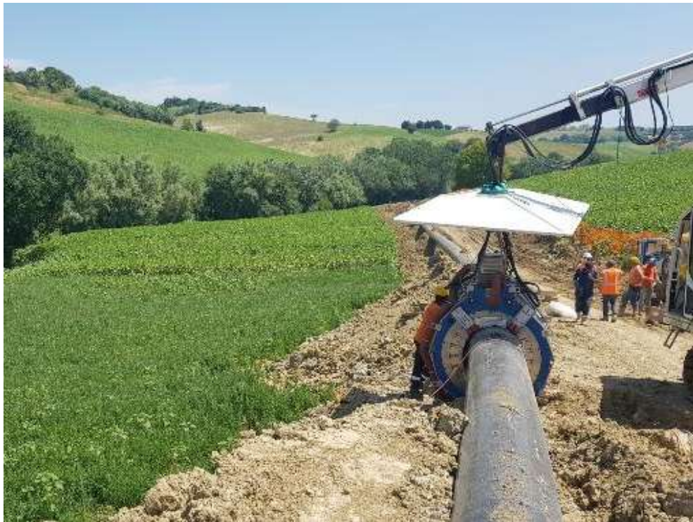
Figura 2-13 – Esempio di saldatura automatica
