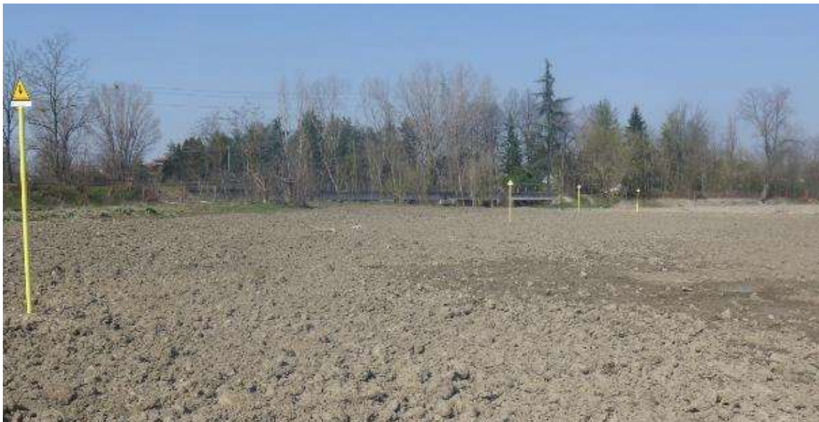
Figura 2-29 – Pista lavori, su terreno agricolo, a ripristini ultimati; si nota la disposizione delle paline segnaletiche su metanodotto in esercizio
