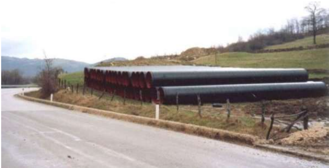
Figura 2-8 – Piazzola di accatastamento tubazioni
