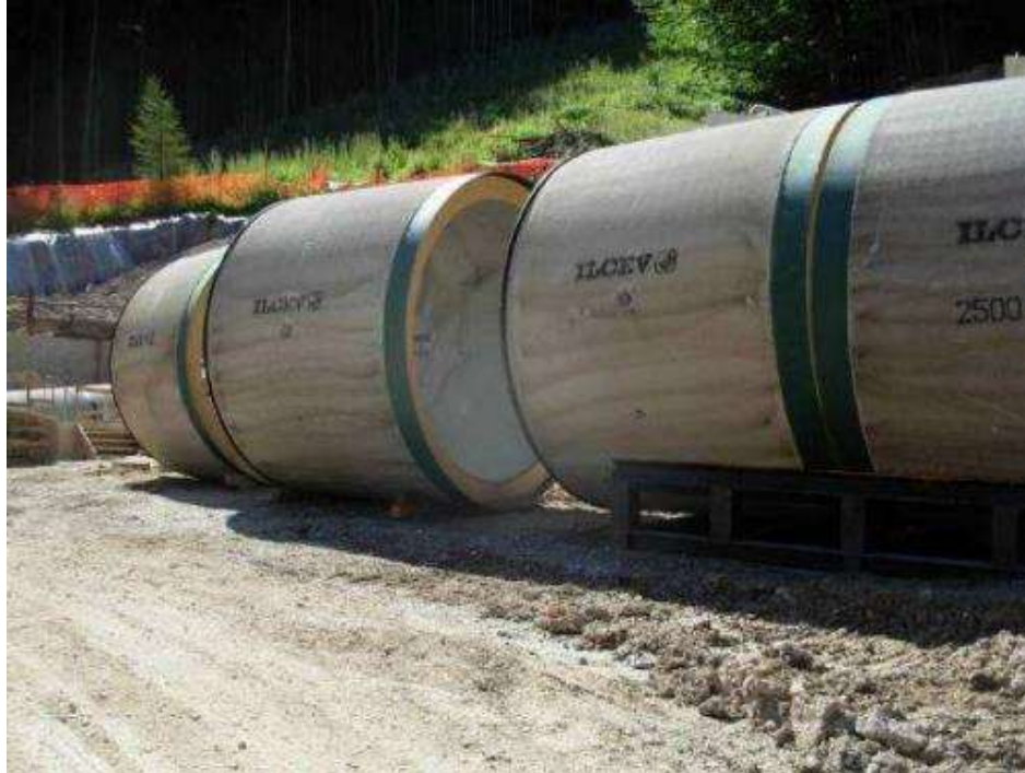
Figura 2-27 – Stoccaggio tubi in c.a.
