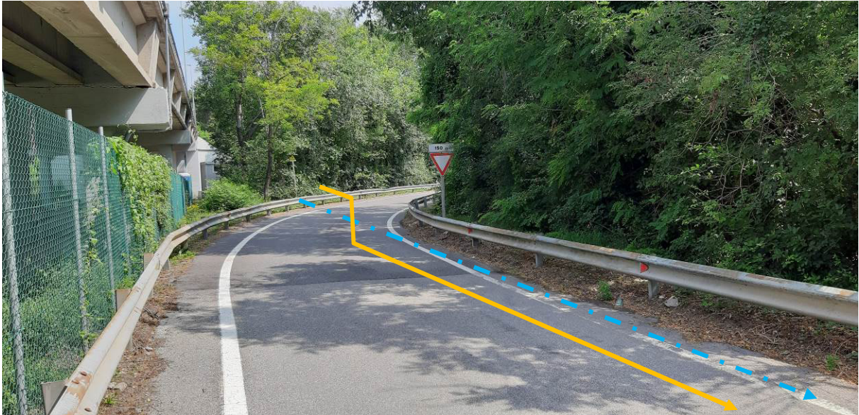
Foto n.19A – Percorrenza della corsia di immissione della SS n.14
