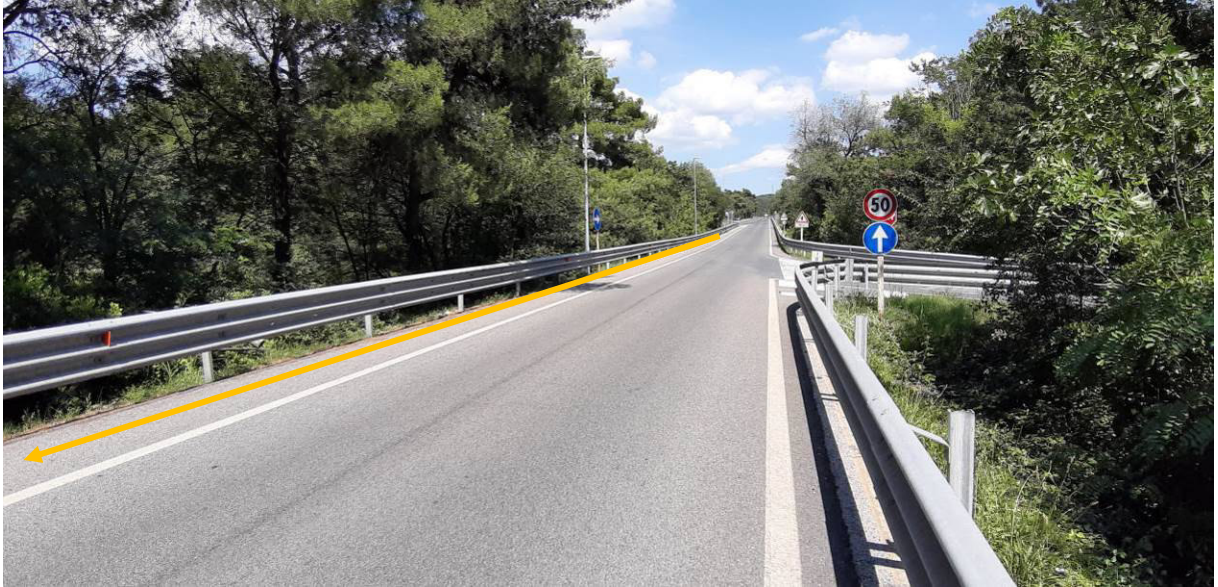
Foto n.7A – Percorrenza SS n.14/55 r.
