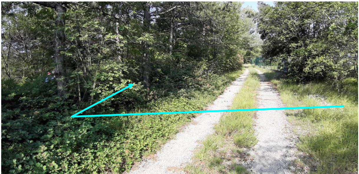
Foto n.2B – Attraversamento della strada sterrata di accesso all'esistente cabina n.906/A ed inizio parallelismo con la strada sterrata
