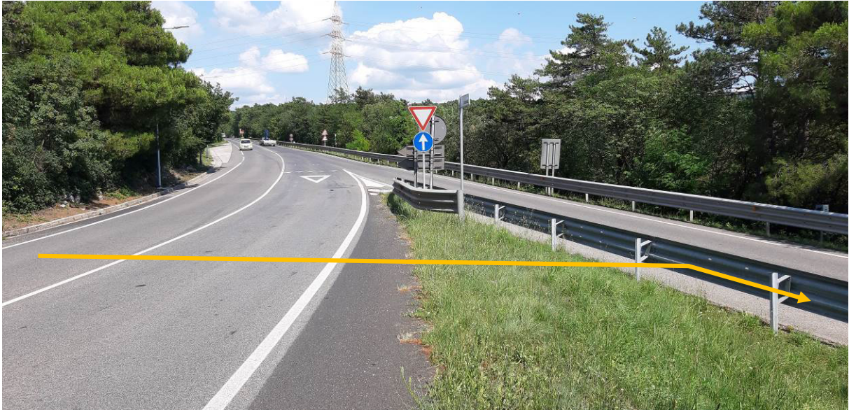
Foto n.3A – Attraversamento via Locavaz
