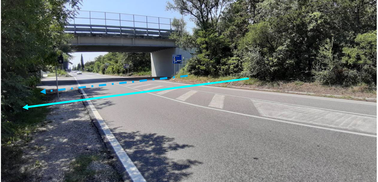
Foto n.13B – Attraversamento SS n.14
