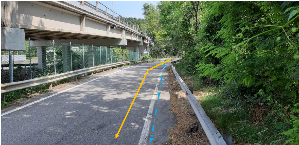
Foto n.20A – Percorrenza della corsia di immissione della SS n.14
