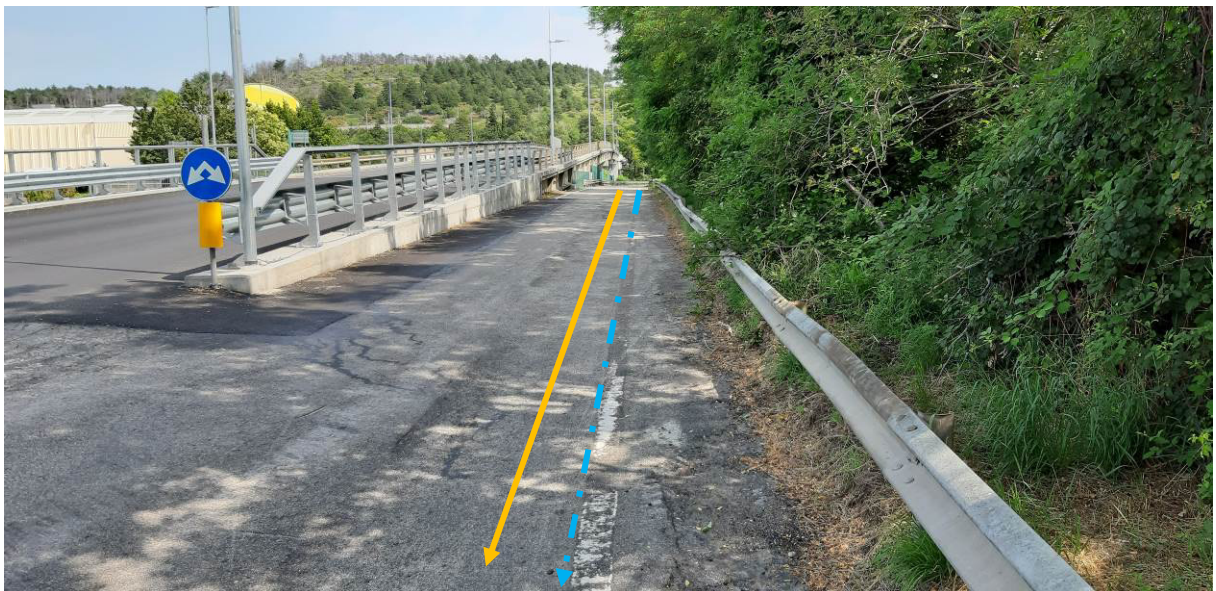
Foto n.24A – Percorrenza della corsia di immissione della SS n.14
