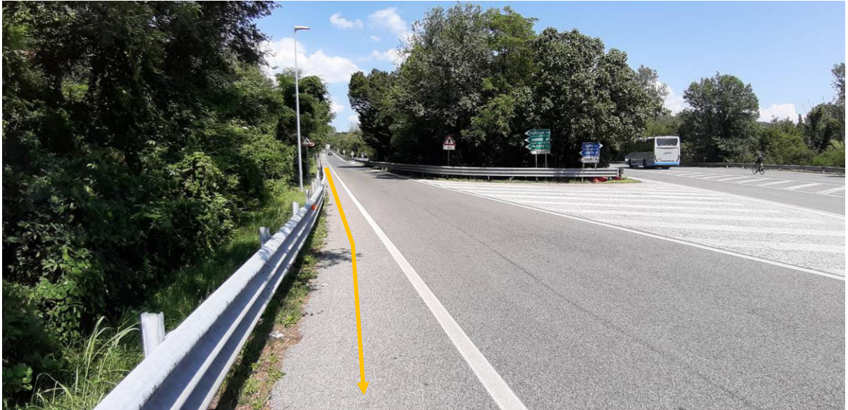
Foto n.11A – Percorrenza SS n.14/55 r.
