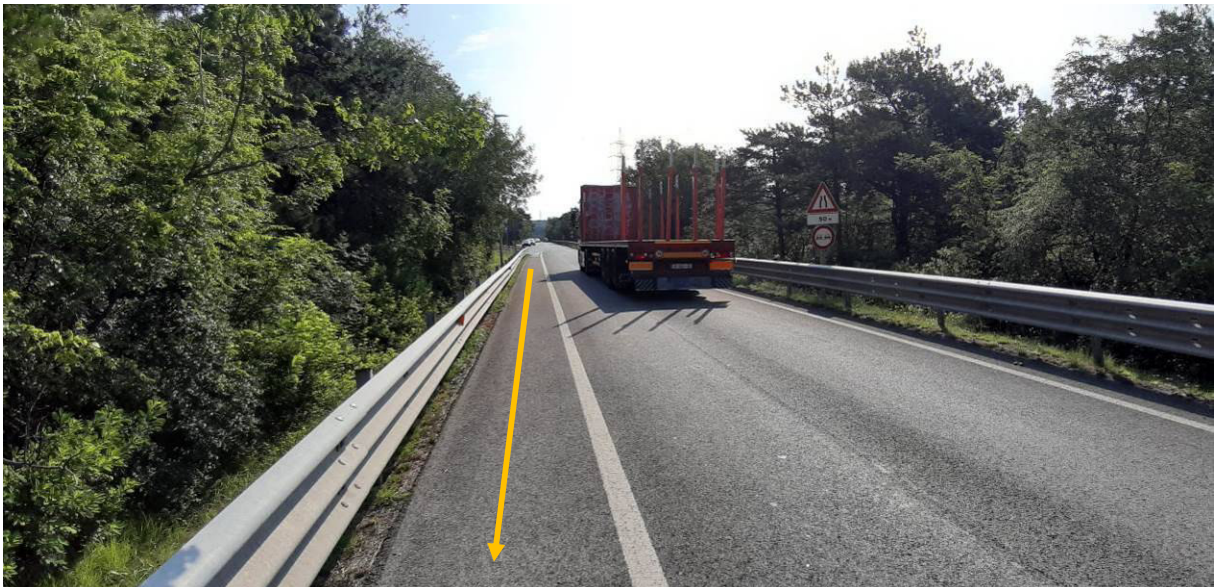
Foto n.6A – Percorrenza SS n.14/55 r.
