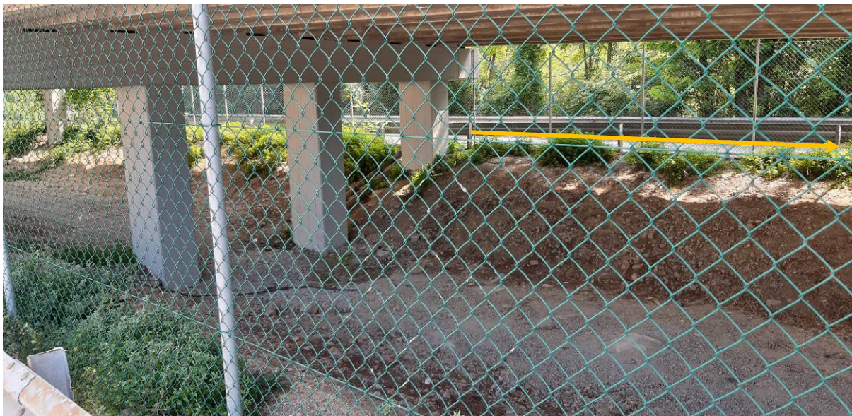
Foto n.21A – Percorrenza della corsia di immissione della SS n.14
