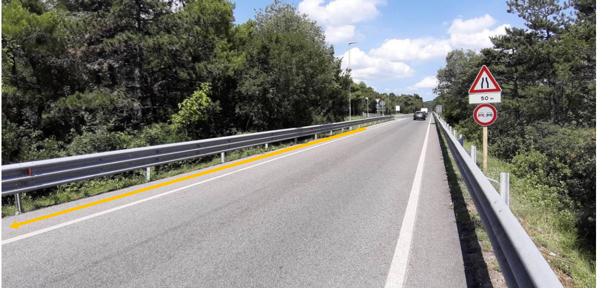
Foto n.5A – Percorrenza SS n.14/55 r.
