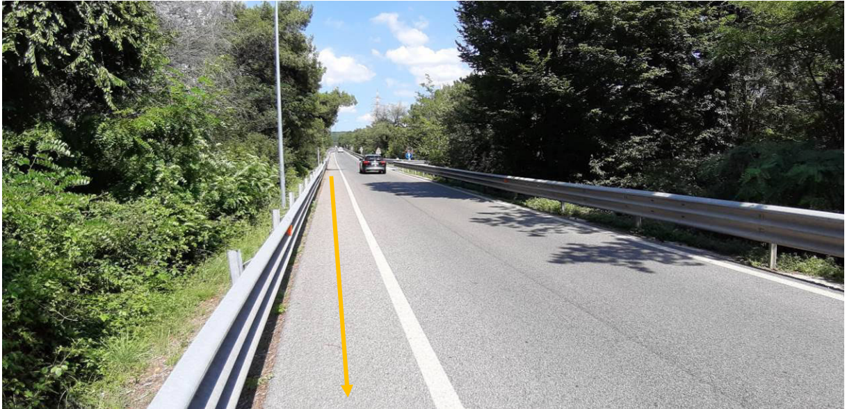
Foto n.9A – Percorrenza SS n.14/55 r.
