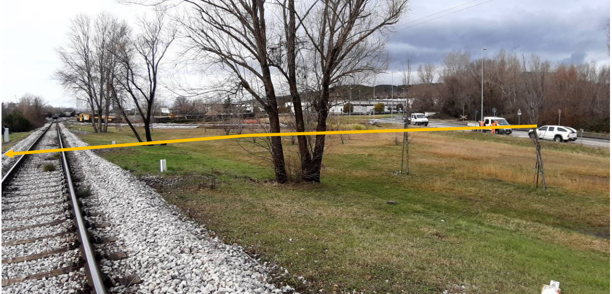
Foto n.31A – Panoramica dell'area compresa tra il primo attraversamento di via Consiglio d'Europa e il primo attraversamento del raccordo ferroviario base del Lisert
