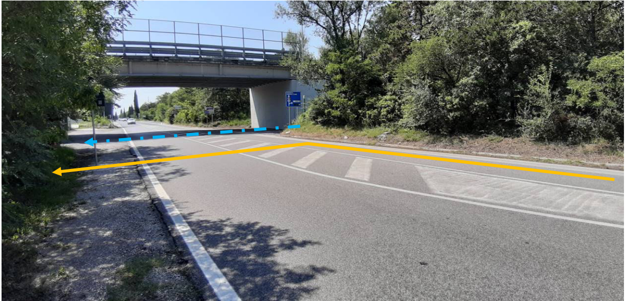
Foto n.15A – Fine percorrenza SS n.14 ed attraversamento perpendicolare della SS n.14
