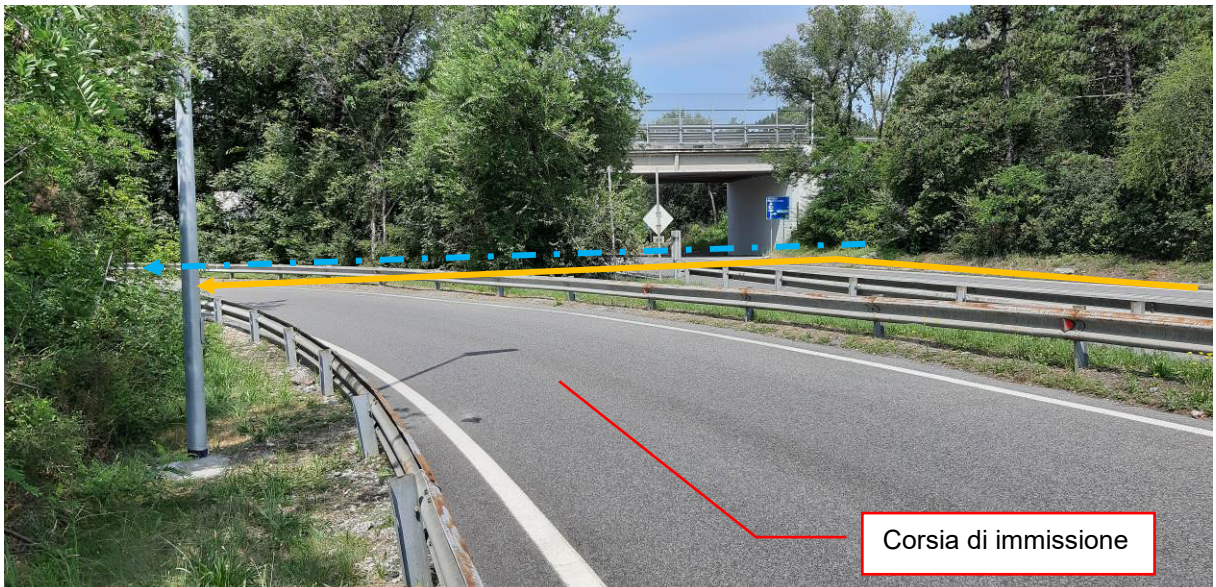
Foto n.16A – Attraversamento spartitraffico tra la SS n.14 e la corsia di immissione
