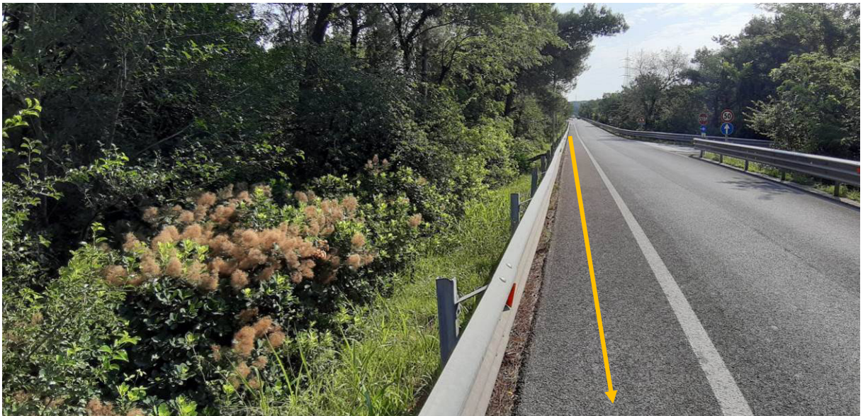
Foto n.8A – Percorrenza SS n.14/55 r.
