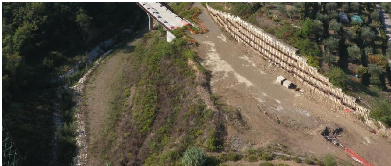
Figura 4.4 Stato Lavorazioni - Paratia MU37, Inalveazione AI14
