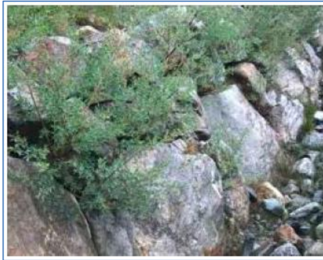
Figura 11.8 -Esempio di scogliera rinverdita con talee
