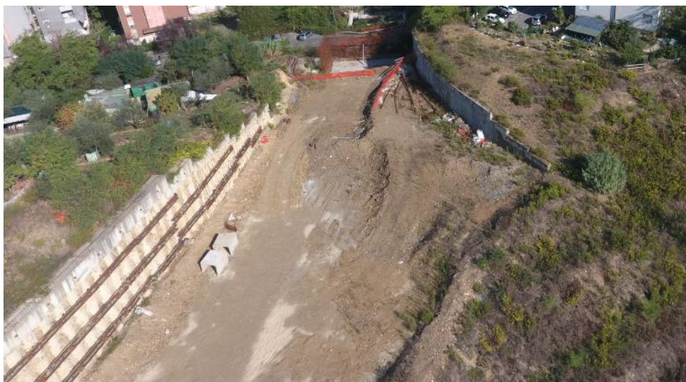
Figura 4.3 Stato Lavorazioni - Paratie MU35 e MU37
