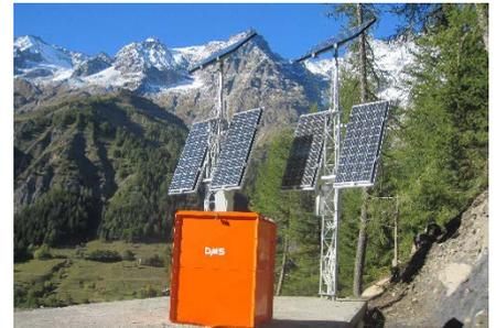
Esempio di sistema di alimentazione fotovoltaico a 6 pannelli.
