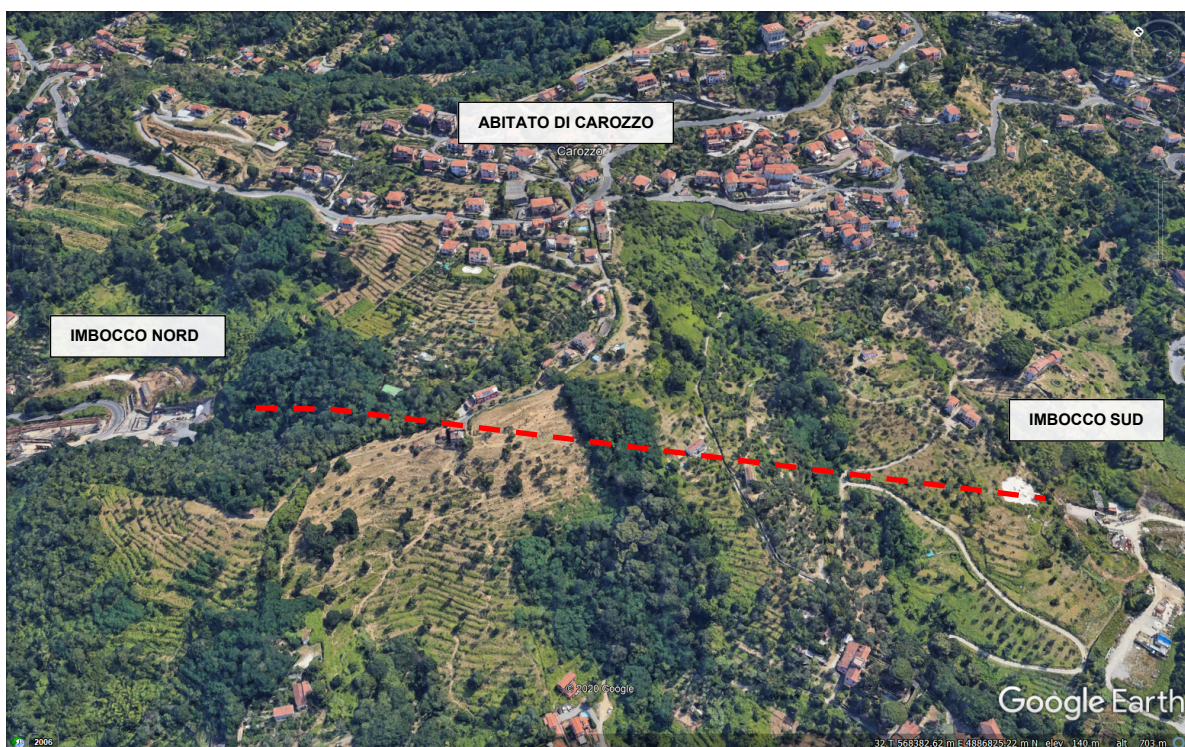
Figura 1: Vista dell'area della galleria Felettino I adiacente all'abitato di Carozzo (In rilievo).
