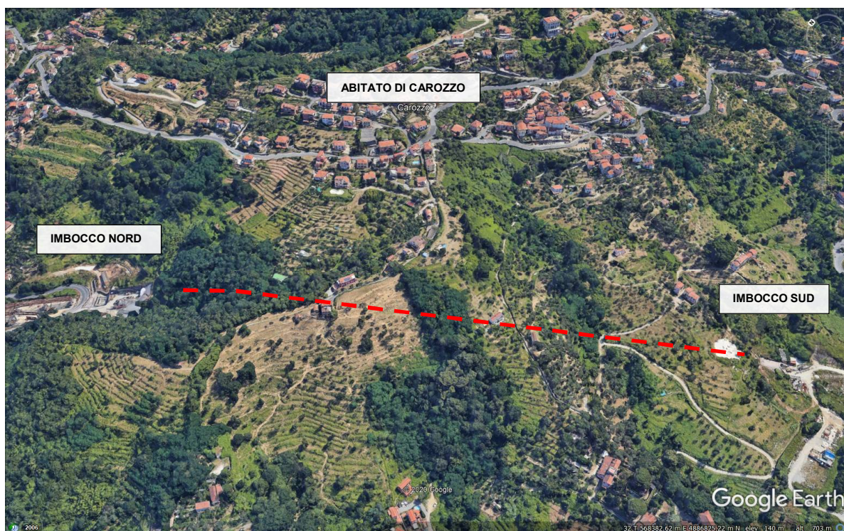
Figura 1: Vista dell'area della galleria Felettino I adiacente all'abitato di Carozzo.
