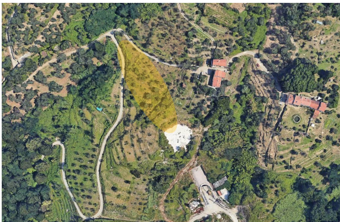
Figura 2: Vista della zona interessata dallo scavo della galleria artificiale in prossimità dell'imbocco Sud.
