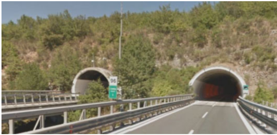
Figura 4-3 Vista imbocchi lato Roma
