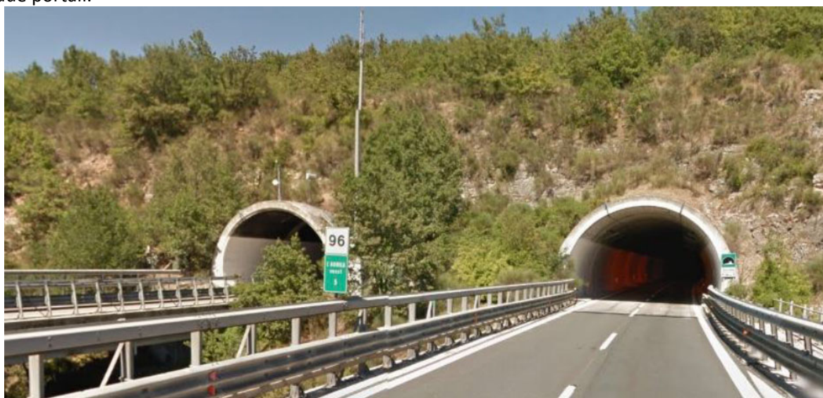
Figura 5-9 – Vista imbocchi lato Roma
