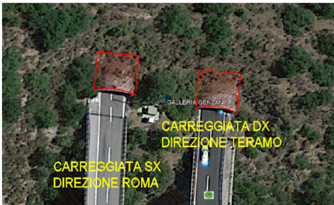
Figura 5-8 – Imbocchi lato Roma: indicazione delle aree di intervento di risanamento previste.
