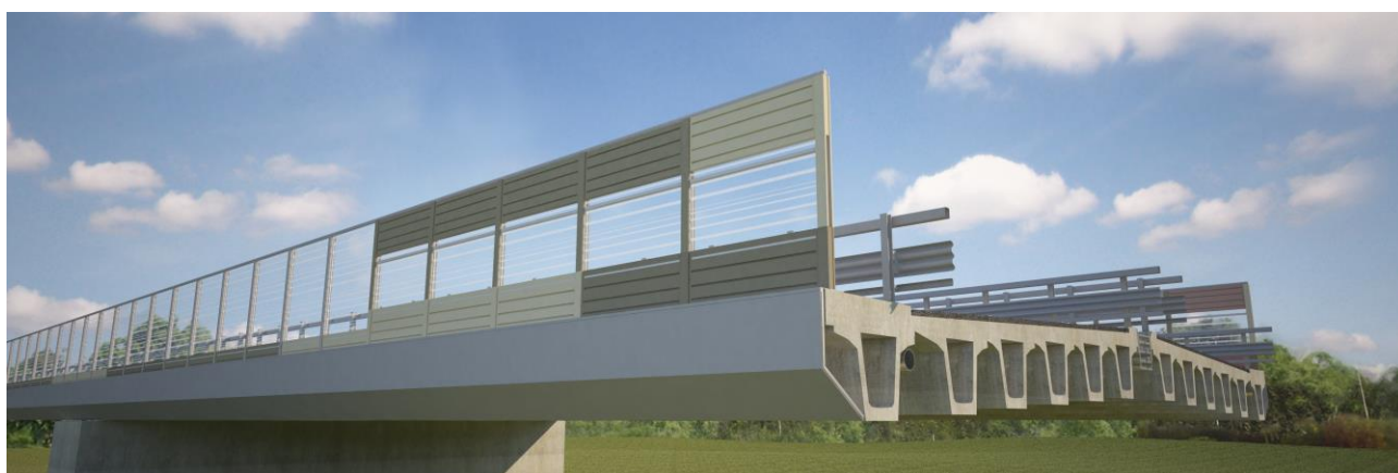
FIGURA 4-30 – SOLUZIONE ARCHITETTONICA VIADOTTO CON IMPALCATO IN CAP
