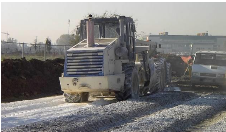
FIGURA 4-41 – STABILIZZAZIONE DELLE TERRE – MISCELAZIONE MEDIANTE PULVIMIXER.
