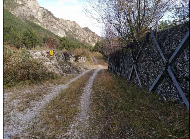
**Figura 13** Vista in direzione E delle opere di messa in sicurezza del dissesto Cod.Per. 0302043600B-CR
