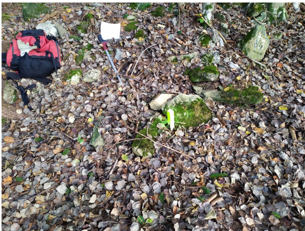
Figura 5-8: Segnalazione del centro del punto di rilievo per il nuovo sostegno n. 2/1.
