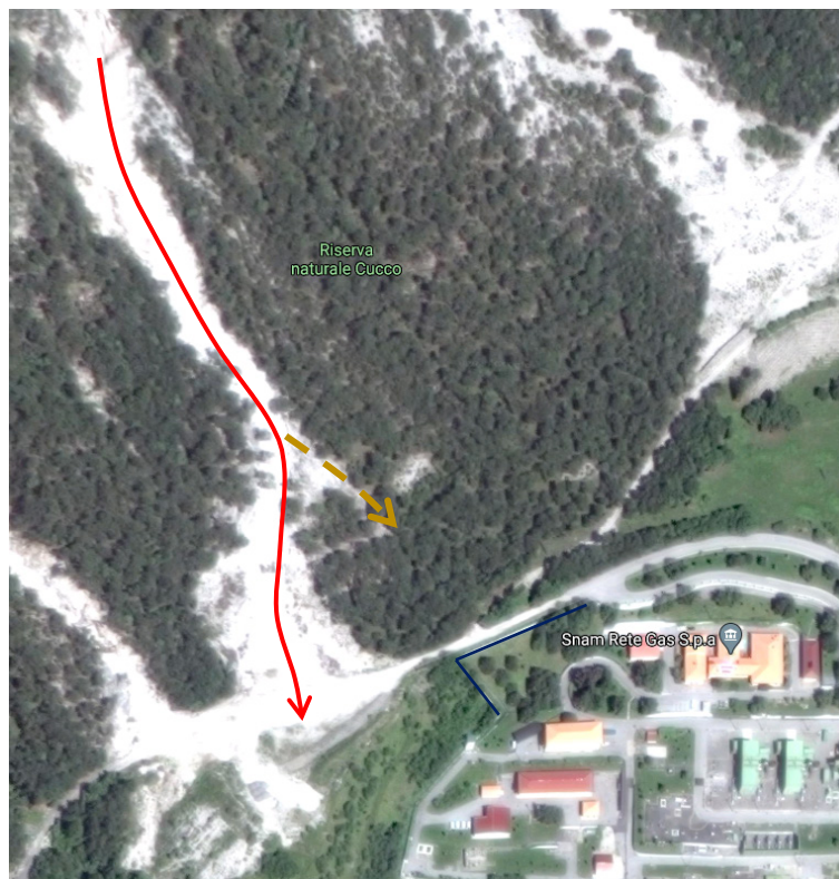
Foto 17: in rosso il canale principale della colata. In arancione la possibile fuoriuscita di materiale residuale in direzione della strada ex SS13. In blu la recinzione a valle delle quale sono previsti i lavori di adeguamento dell'impianto
