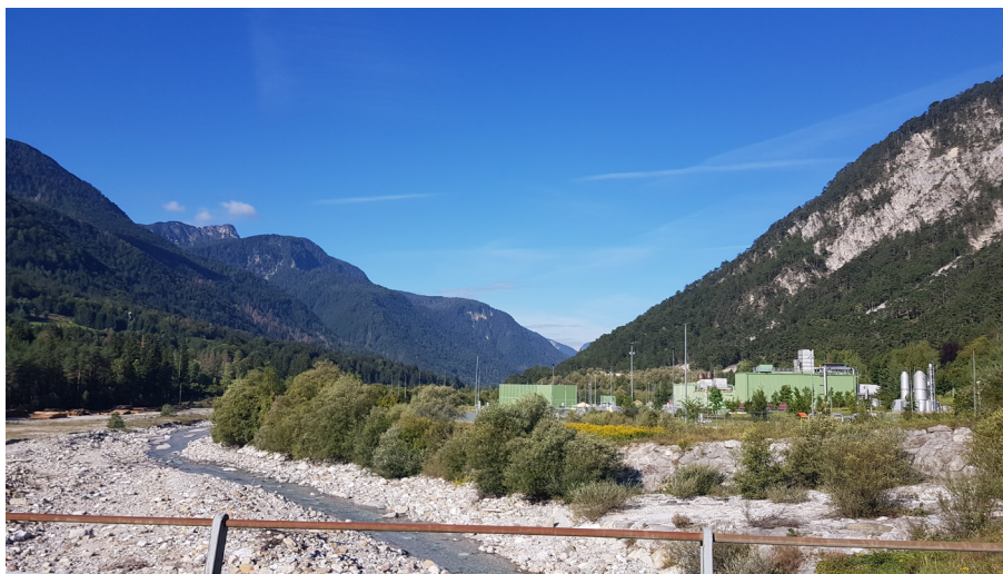
Foto 9: l'impianto ubicato nella valle con il torrente Fella in primo piano
