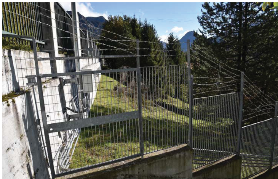
Figura 2. 10 - Ipotesi Area 1 (adiacente impianto SNAM) – documentazione fotografica
