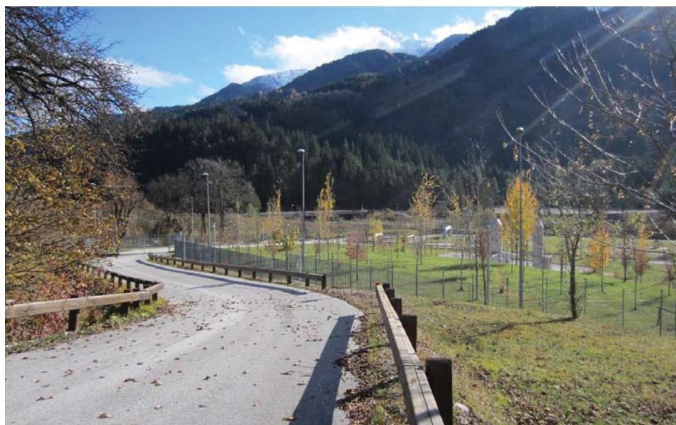
Figura 2.12 - Ipotesi Area 2: Vista verso il Ponte sul Fiume Fella
