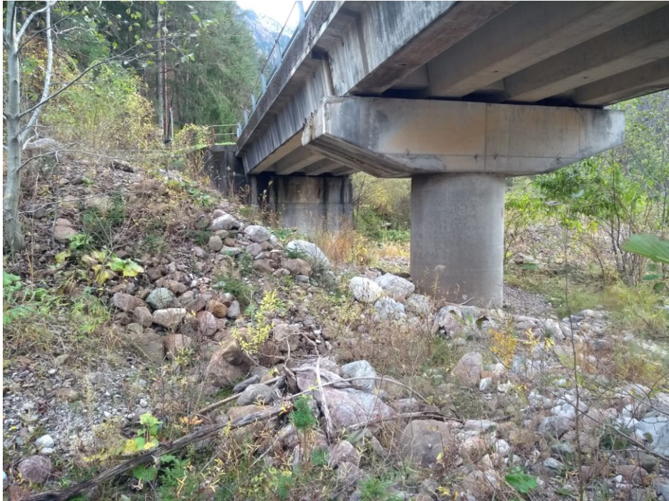
Figura 6 – Particolare della pila e della spalla su sponda sx del ponte sul fiume fella in località Cucco
