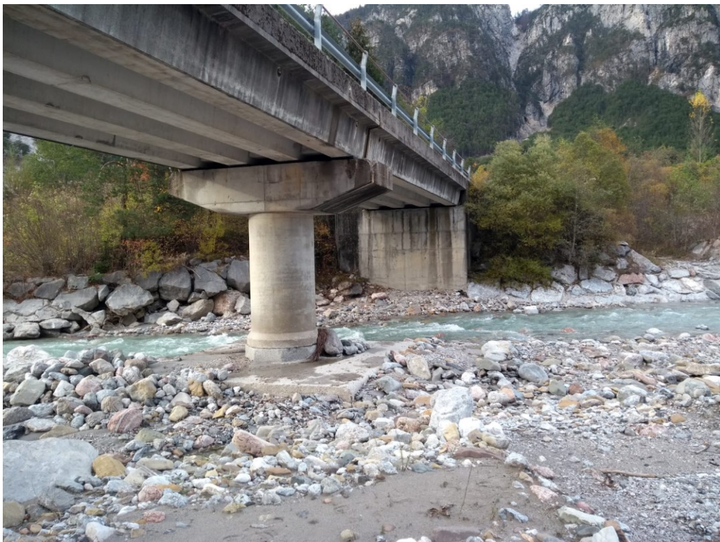
Figura 7 – Particolare della pila e della spalla su sponda dx del ponte sul fiume fella in località Cucco
