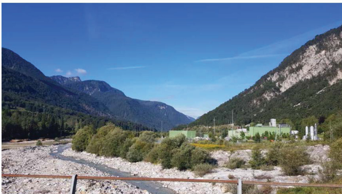
Figura 2.1/A – Foto panoramica dell'area di attraversamento (vista dal ponente verso valle idrografica). A destra la stazione di compressione Snam
