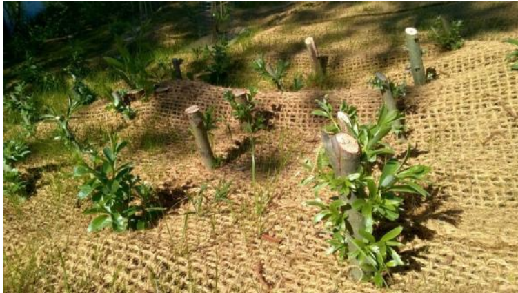
Posa di rivestimento antierosivo in juta (Roggia Vernavola, Pavia)
