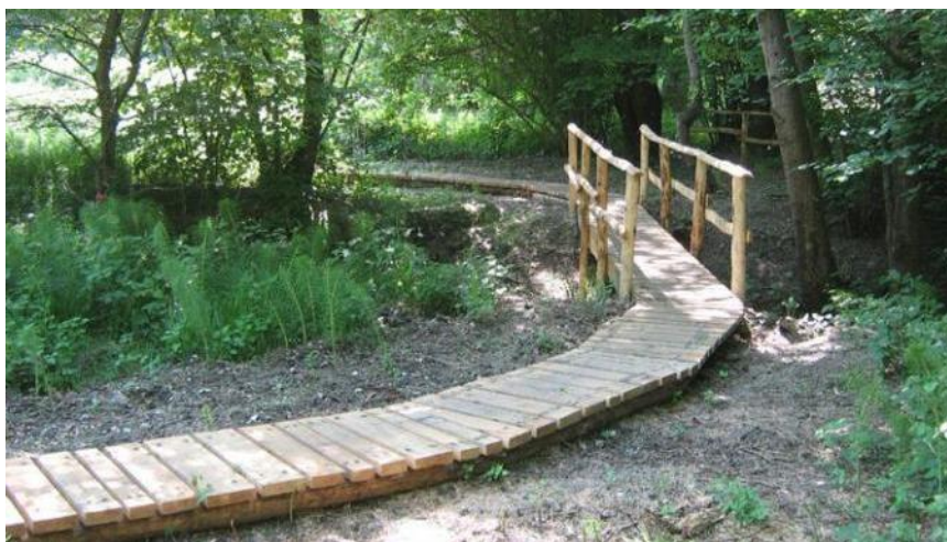
Esempio realizzativo di passerella rialzata in legname.
