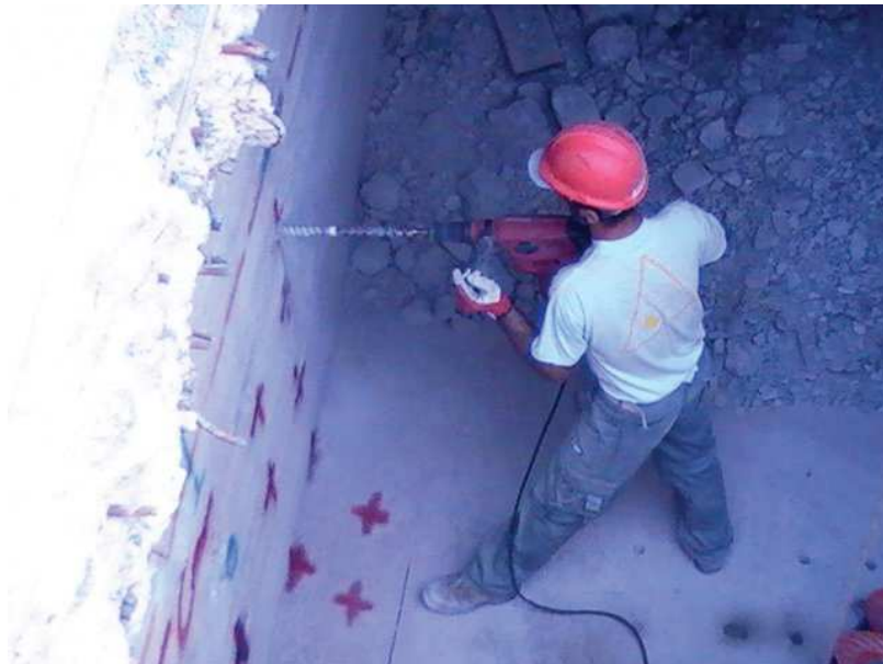
Perforazione con martello elettrico
