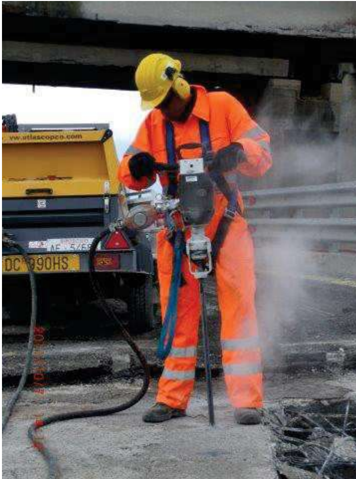
Perforazione pneumatica
