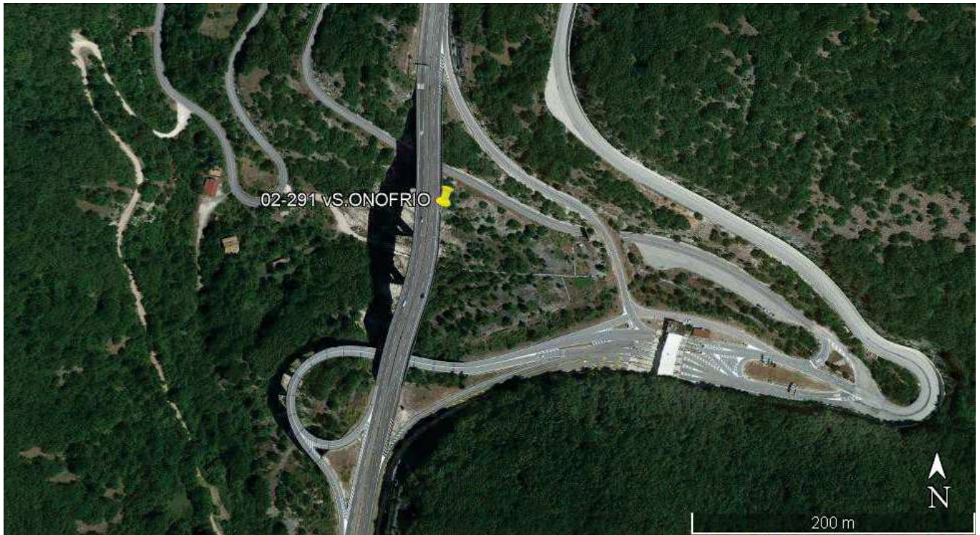
Foto 1.1.3.i: Viadotto S.ONOFRIO. Intersezione con un impalcato di una rampa autostradale (I1 - non oggetto di abbattimento con esplosivi) e con una strada provinciale (I5)
