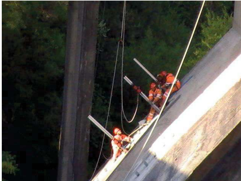
Perforazione a carotaggio
