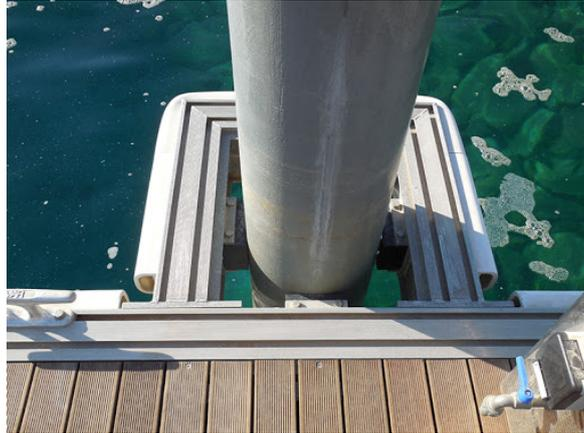
**Figura 37 - Esempio palo e sistema scorrevole**
