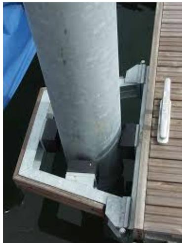
**Figura 38 - Esempio palo e sistema scorrevole**
