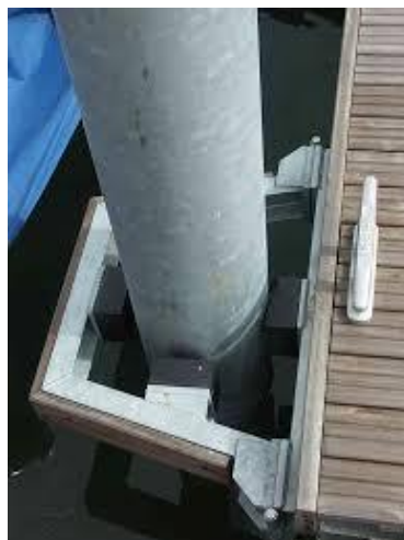
Figura 13 Esempio palo e sistema scorrevole
