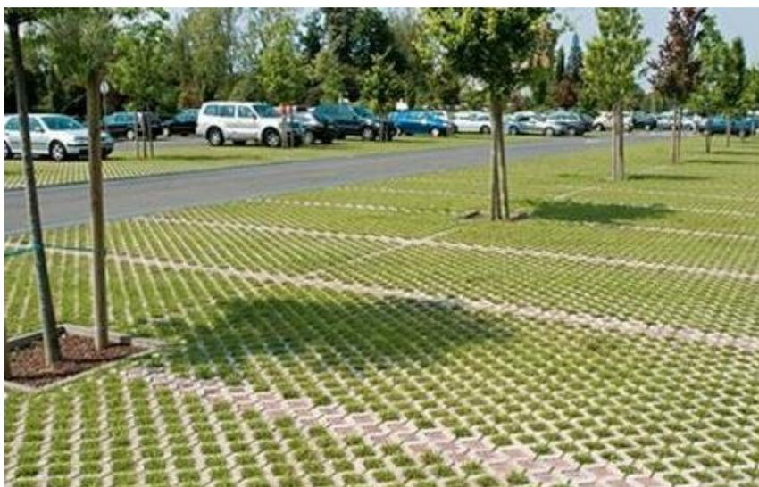
**Figura 63 Esempio di pavimentazione in masselli autobloccanti grigliati**
