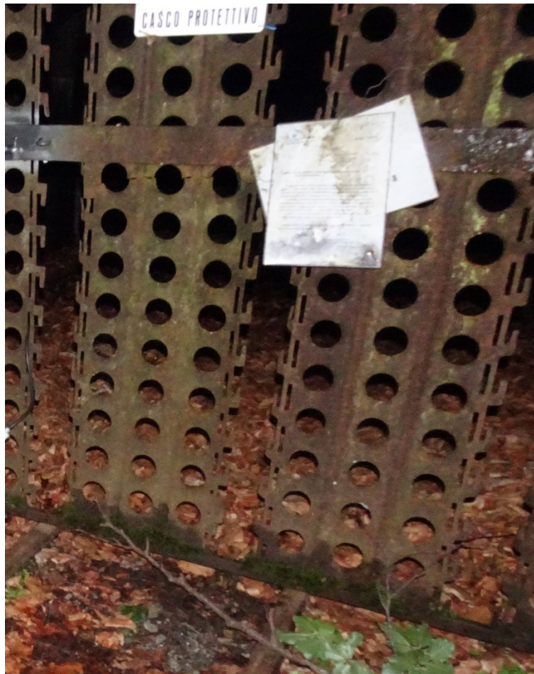
Figura 6 Dettaglio delle piastre di ferro che costituiscono lo sbarramento al portale Riso.
