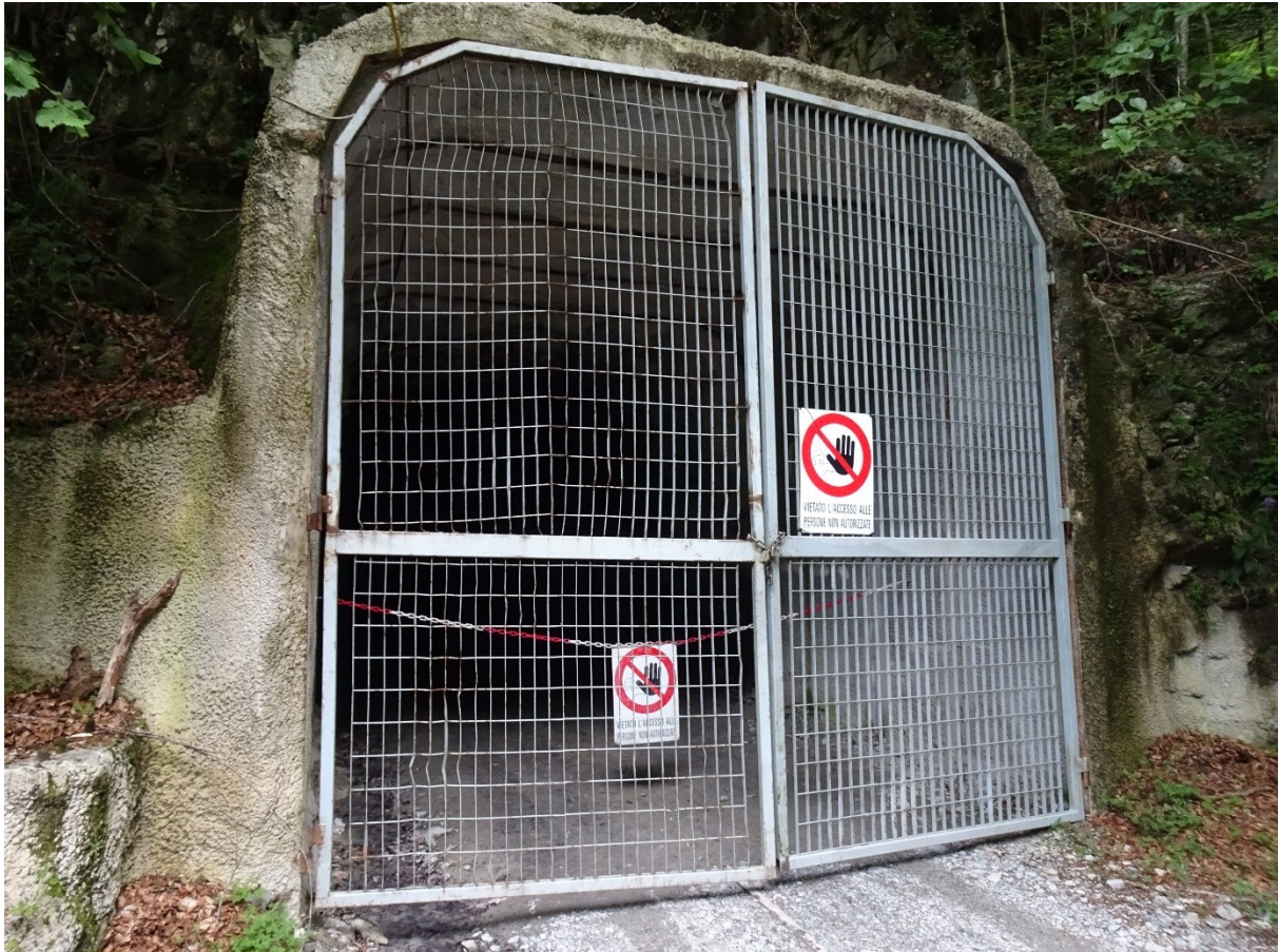
Figura 10 Cannello del Portale Forcella con grigliato a maglia fitta, di larghezza tale da non permettere il passaggio di chiroterri.
