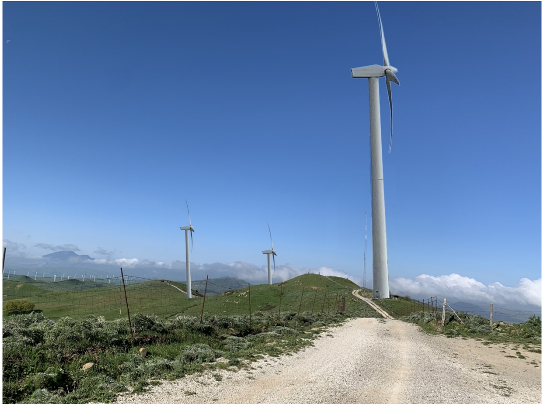
Punto di ripresa n.6 - Stato futuro
