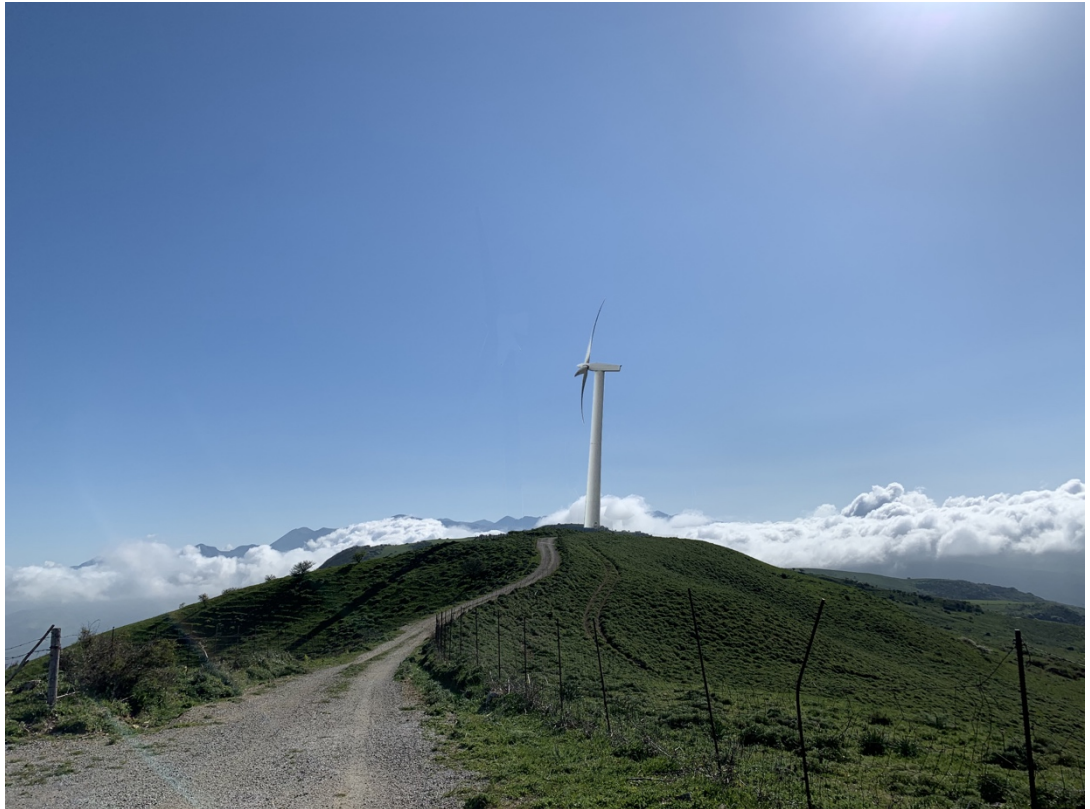
Punto di ripresa n.13 - Stato futuro
