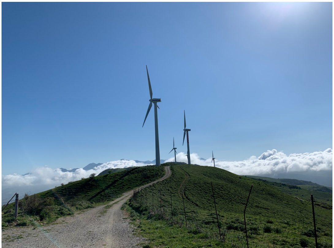
Punto di ripresa n.13 - Stato futuro
