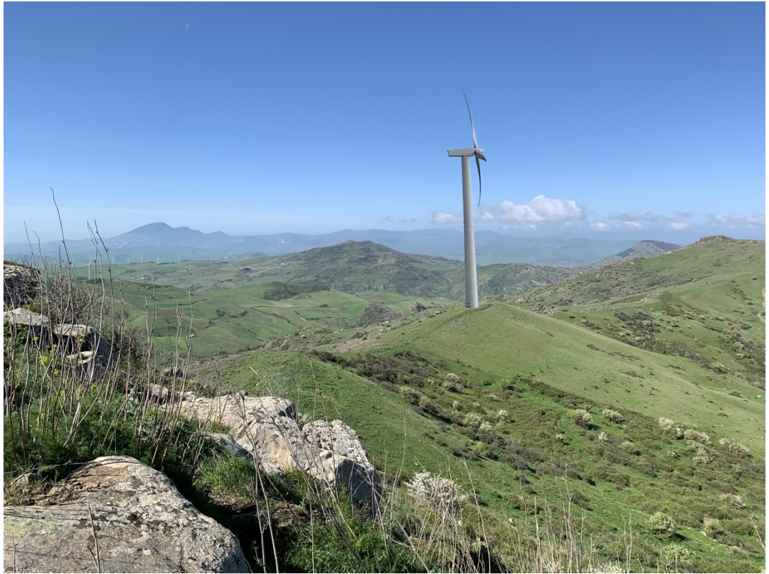
Punto di ripresa n.20 - Stato futuro
